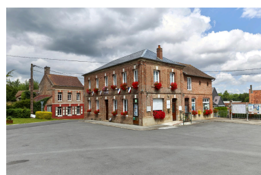
Vue d'ensemble de la mairie et de l'ancienne poste depuis le sud-est. Phot. Thierry Lefébure IVR32_20238000555NUCA
