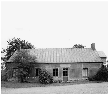
Ancienne mairie, 28 Grande- Rue Phot. Laurent Jumel IVR22_19980202896X
