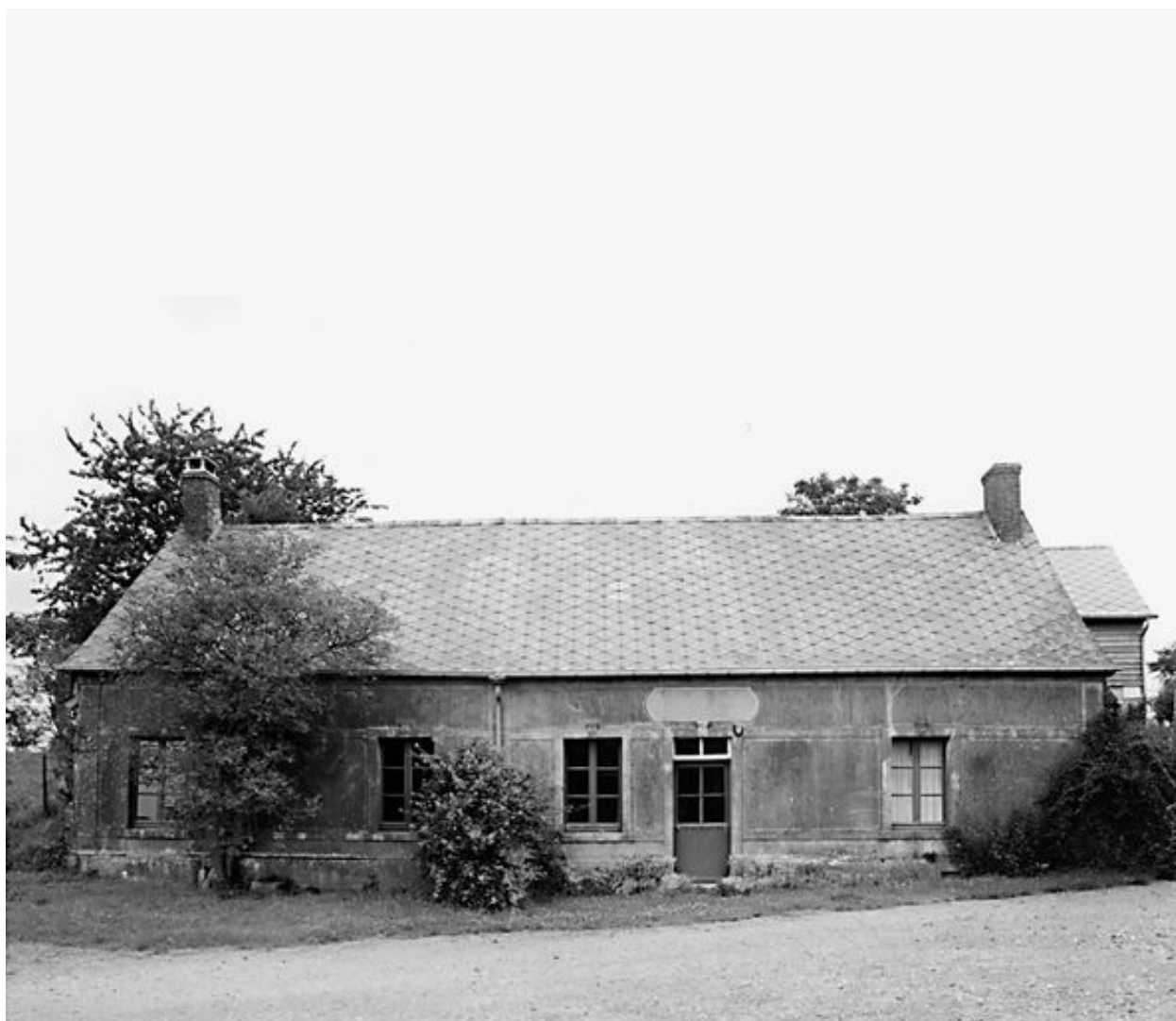
Ancienne mairie, 28 Grande- Rue
