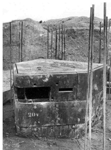
L'observatoire cuirassé pentagonal assemblé. Ici mis en place sur une casemate avant coulée du couvrement. IVR32_20175900442NUCA
