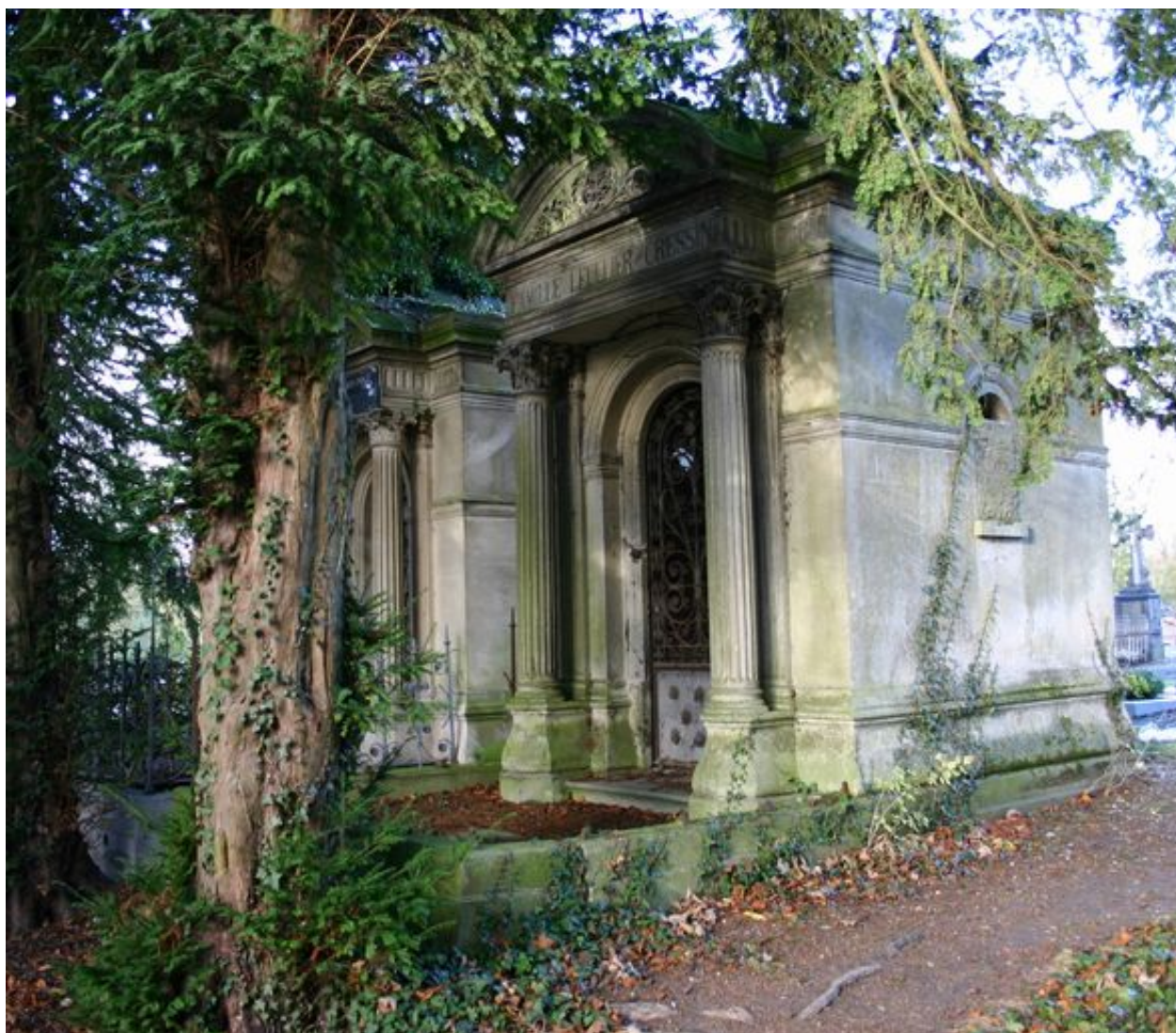
Vue générale, depuis le côté.
