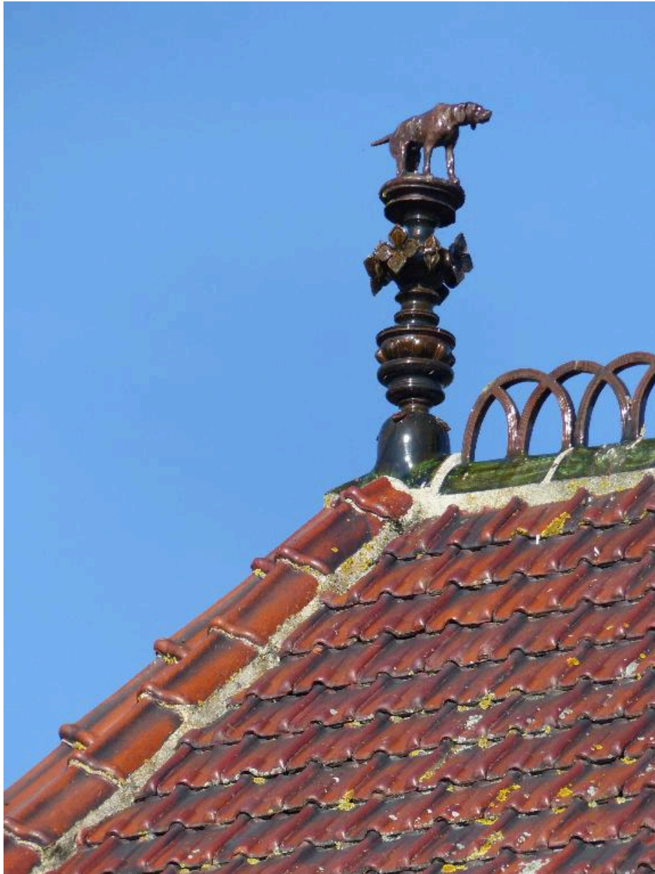
Vue de détail sur l'épi de faitage.
