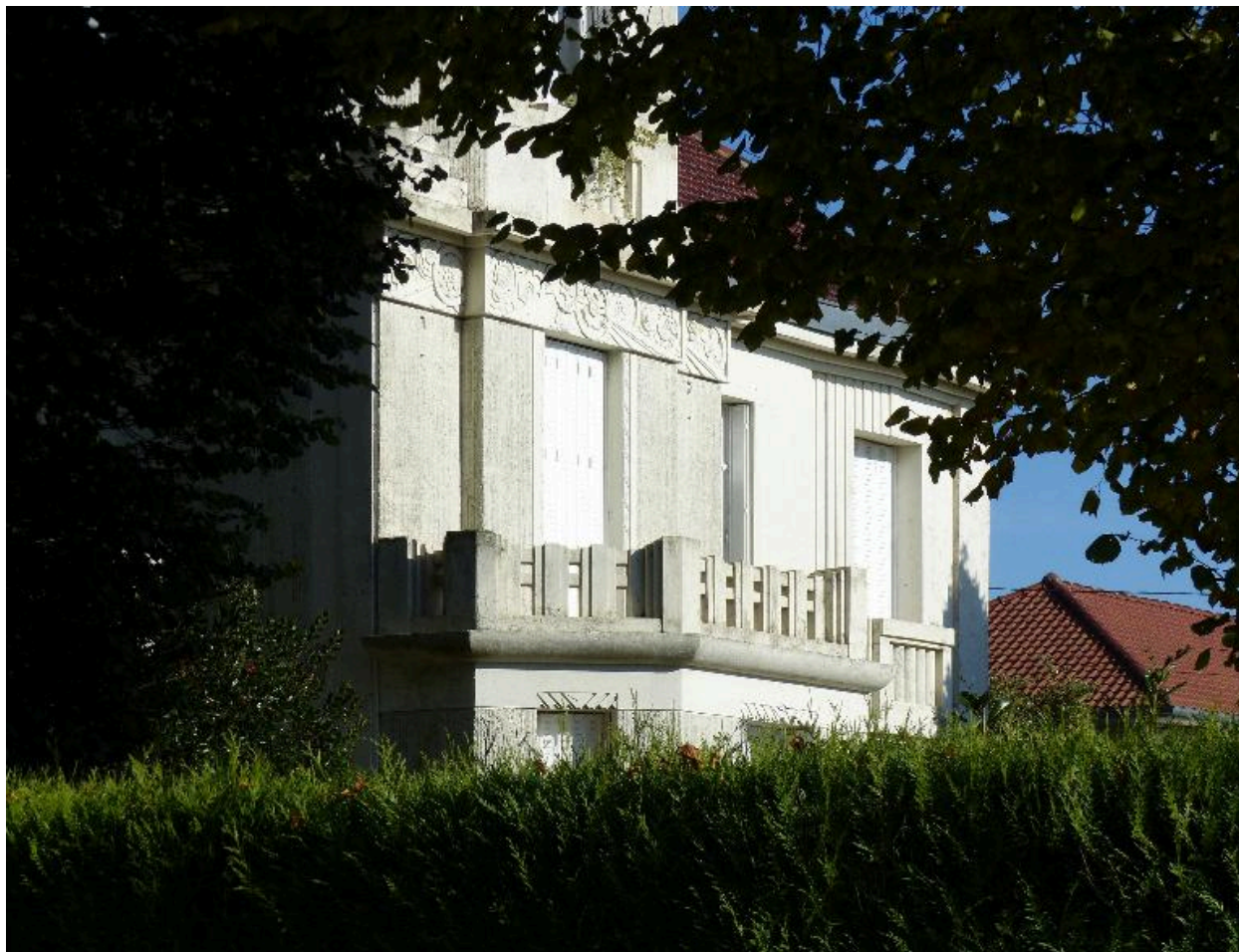
Vue de détail sur le décor Art-Déco de la façade sur rue.
