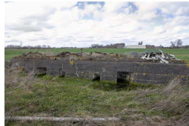
Elévation antérieure (sud-est). On aperçoit les entrées latérales et les resserres à mitrailleuses Phot. Jean-Marc Ramette IVR31_20145904051NUCA
