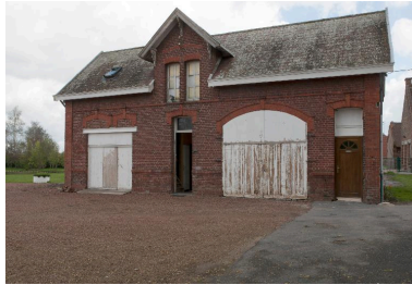
Dépendances (?) de l'ancienne maison devenue mairie.
