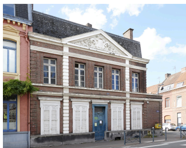
Vue générale de la façade. Phot. Delphine Volto Jourdan IVR32_20265900030NUCA
