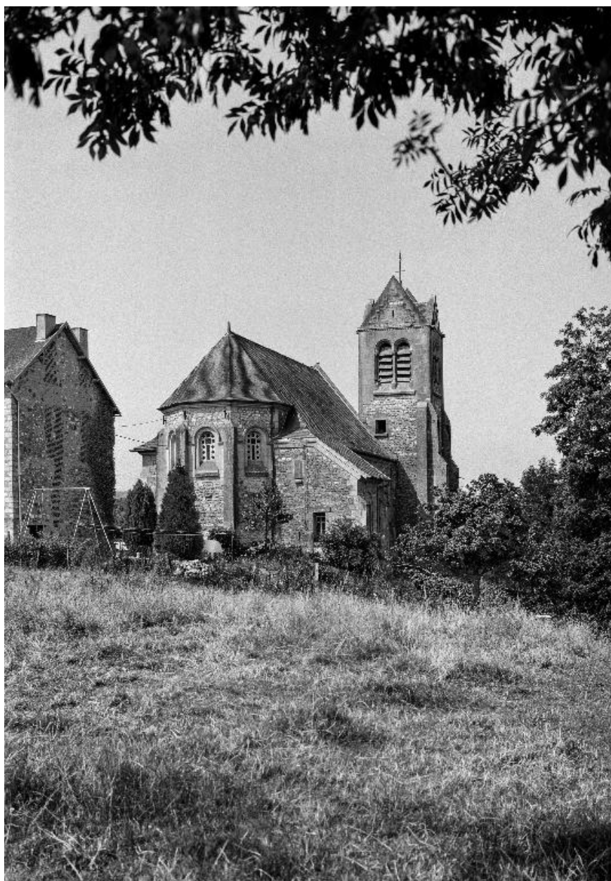
Vue d'ensemble de l'édifice depuis le nord-est.
