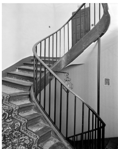
La cage d'escalier. Phot. Thierry Lefébure IVR22_19930202070V
