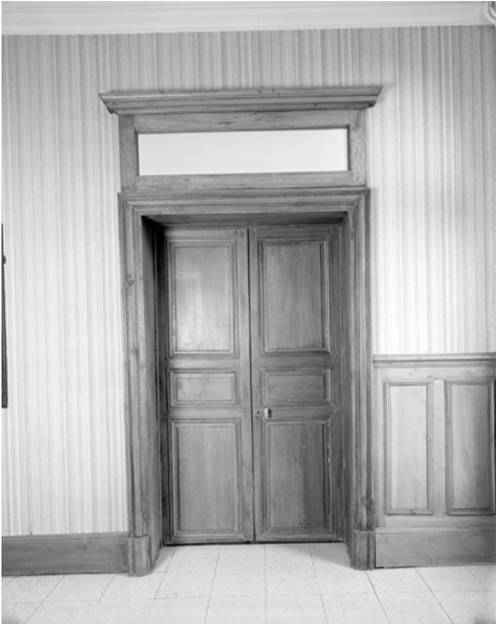
Une porte du vestibule donnant sur le salon.
