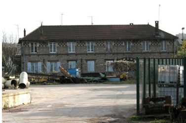
Les logements vus depuis l'usine. Phot. Clarisse Lorieux IVR22_20066005119NUCA
