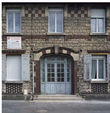
Entrée des logements. Phot. Thierry Lefébure IVR22_20106000658XA
