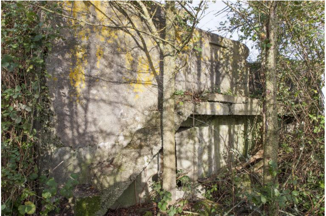
Elévation sud. Escalier menant à la banquette de tir
