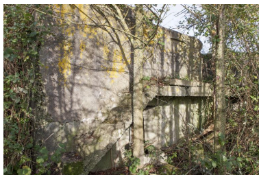
Elévation sud. Escalier menant à la banquette de tir Phot. Pierre Thibaut IVR31_20155901992NUCA
