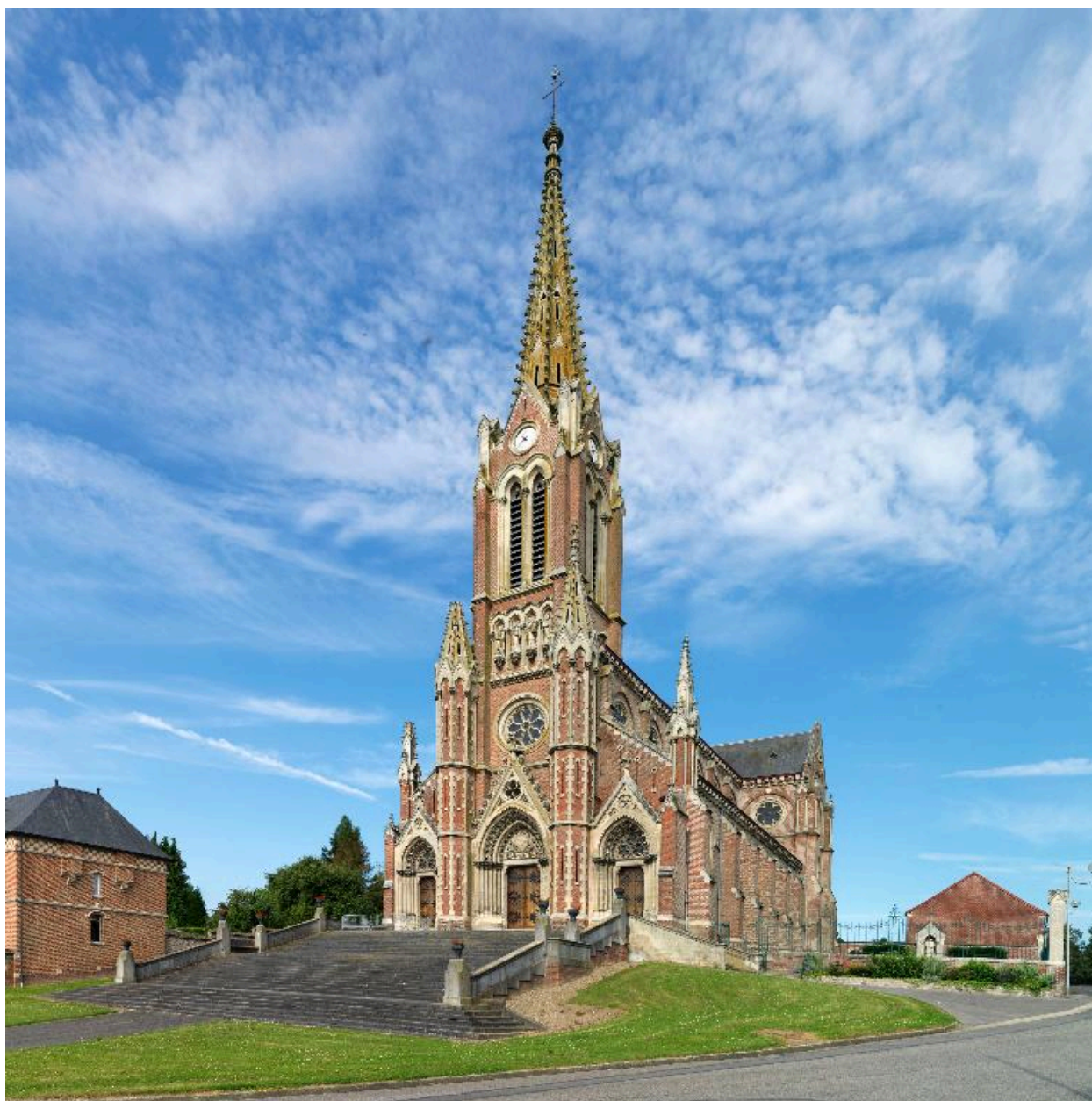
Vue d'ensemble extérieur sud ouest.
