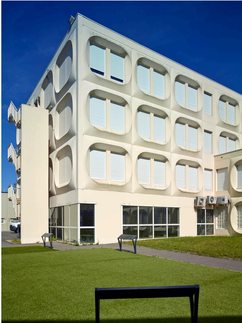
L'angle sud-est du bâtiment d'enseignement ; les baies vitrées correspondent au hall d'entrée.
