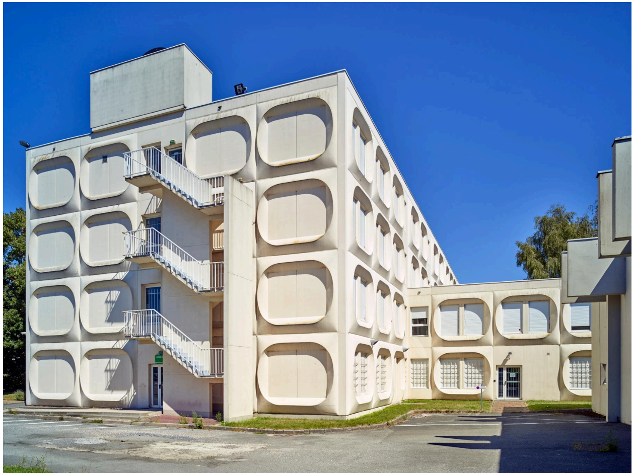
L'angle nord-ouest du bâtiment d'enseignement, depuis le parking ; les ateliers sont visibles à droite.
