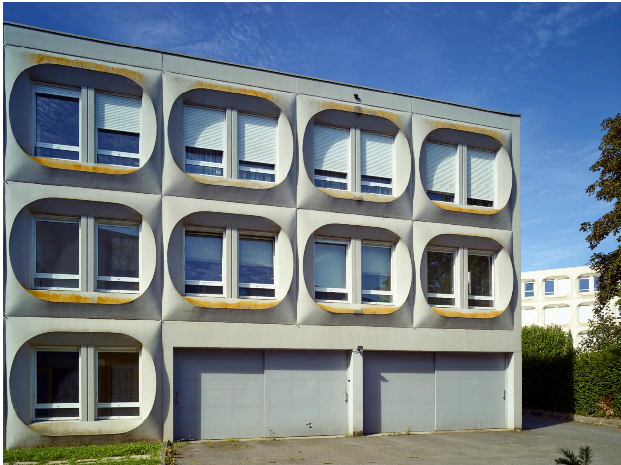
La façade nord-est du bâtiment des logements de fonction, pourvus de garages intégrés.
