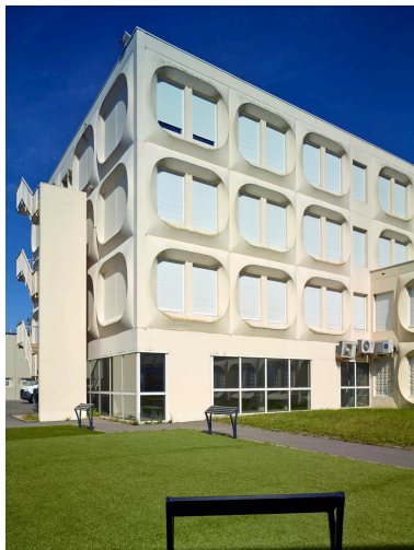
L'angle sud-est du bâtiment d'enseignement ; les baies vitrées correspondent au hall d'entrée. Phot. Pierre Thibaut IVR32_20205902549NUCA
