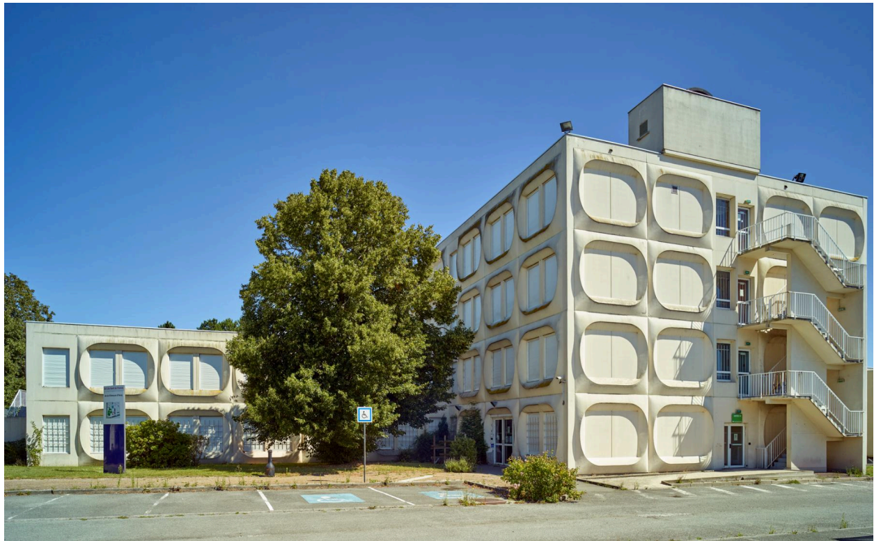
L'angle nord-ouest des bâtiments d'enseignement depuis le parking.
