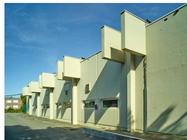
La façade sud des ateliers ; au fond la rue Parmentier. Phot. Pierre Thibaut IVR32_20205902558NUCA
