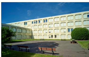
La façade est des bâtiments d'enseignement. Phot. Pierre Thibaut IVR32_20205902584NUCA
