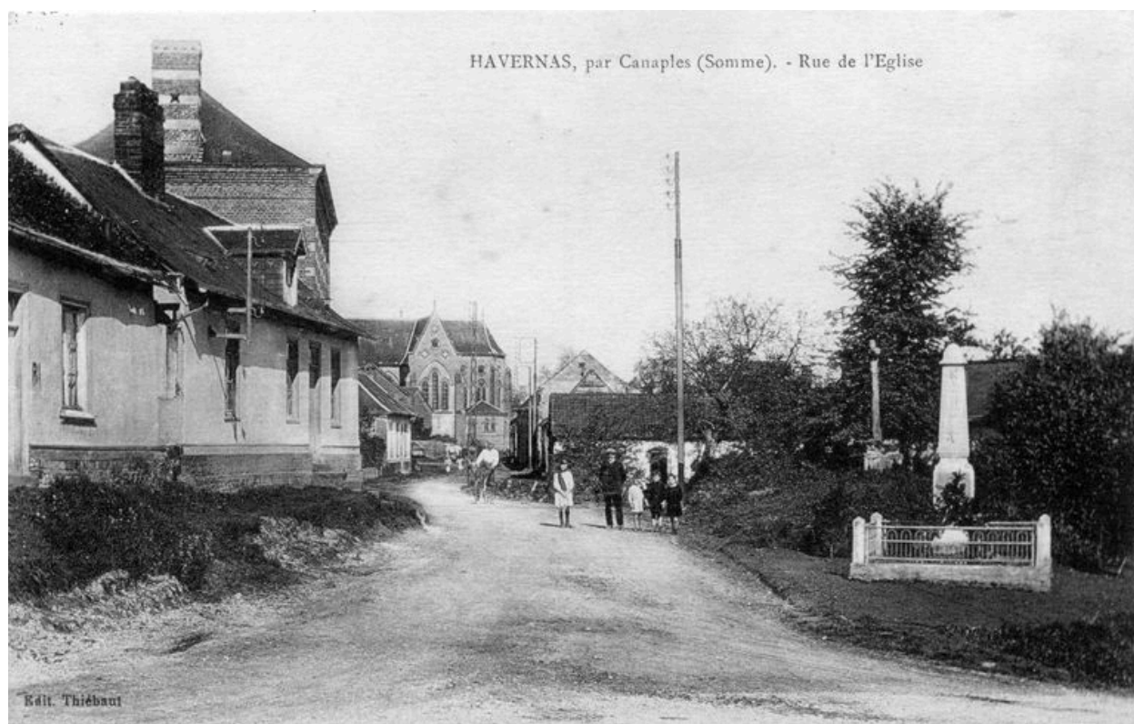
Rue de l'Eglise, 1920-1930 (coll. part.).
