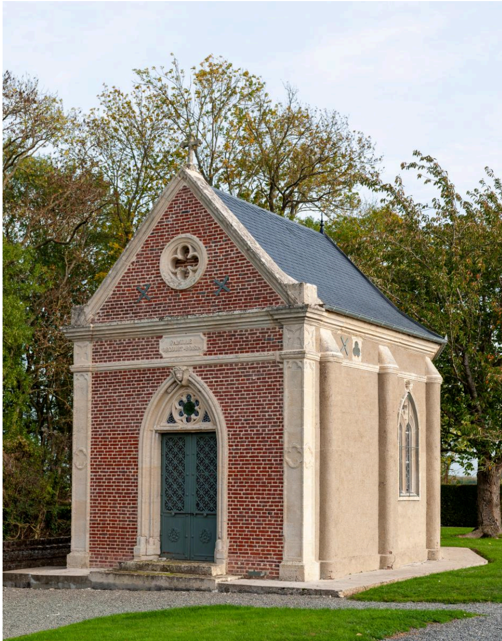
Chapelle funéraire de la famille Decourt-Roisin, vue depuis le nord-ouest.
