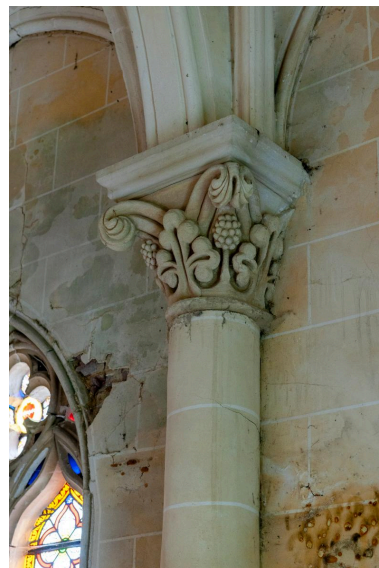
Détail d'un chapiteau. Phot. Marc Kérignard IVR32_20226001168NUCA
