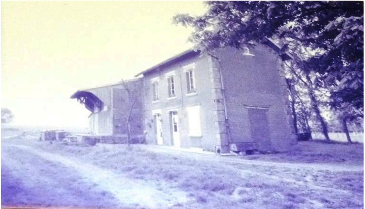
Vue de la gare de Saint-Quentin-la-Motte-Croix-au-Bailly, dans les années 1950 (coll. part.).
