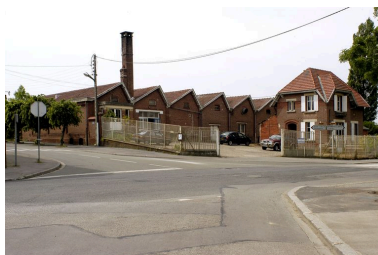
Vue d'ensemble sur rue des ateliers et de la maison patronale. Phot. Thierry Lefebure IVR22_20056000136NUCA
