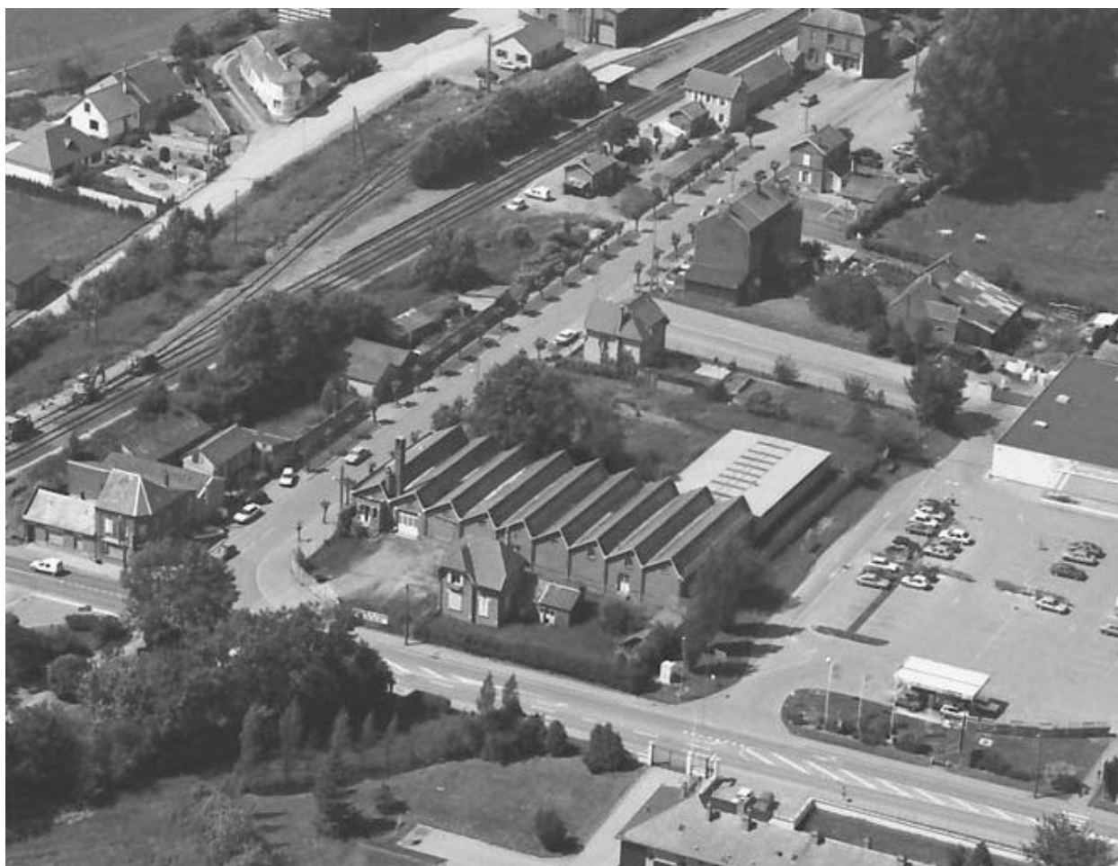
Vue aérienne de l'usine en 1994.
