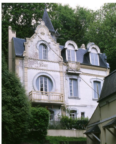
Vue d'ensemble depuis l'avenue. Phot. Marie-Laure Monnehay-Vulliet IVR22_20058001057XA
