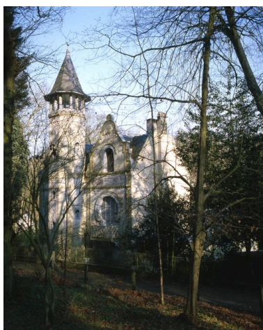
Elévation postérieure. Phot. Marie-Laure Monnehay-Vulliet IVR22_20058000142XA
