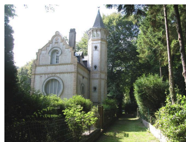
Vue d'ensemble depuis l'allée Marie. Phot. Elisabeth Justome IVR22_20058003312NUCA
