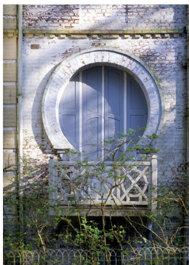
Détail d'une baie de la façade postérieure, devancée par un balcon en bois. Phot. Marie-Laure Monnehay-Vulliet IVR22_20058000145XA
