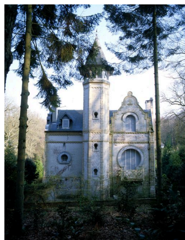
Elévation postérieure. Phot. Marie-Laure Monnehay-Vulliet IVR22_20058000143XA
