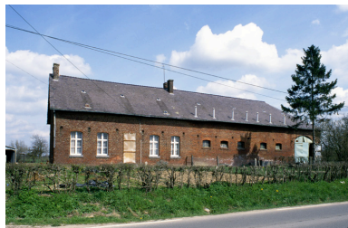
Vue de la ferme est. Phot. Christiane Riboulleau IVR22_19960200476ZA
