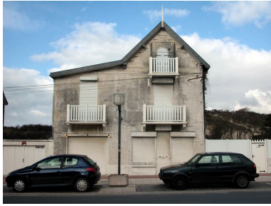
Vue d'ensemble depuis l'avenue de la Plage. Phot. Elisabeth Justome IVR22_20048001464NUCA
