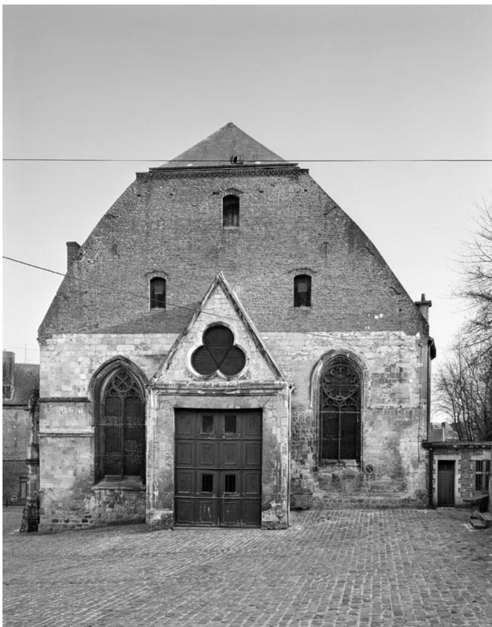
Vue de la façade occidentale.
