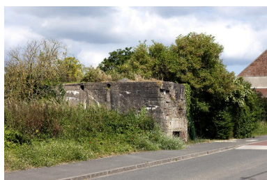
Vue de trois-quarts depuis la rue de sequedin, vers le nord-ouest Phot. Jean-Marc Ramette IVR31_20145904456NUCA
