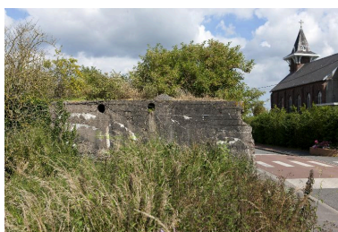
Elévation sud Phot. Jean-Marc Ramette IVR31_20145904458NUCA
