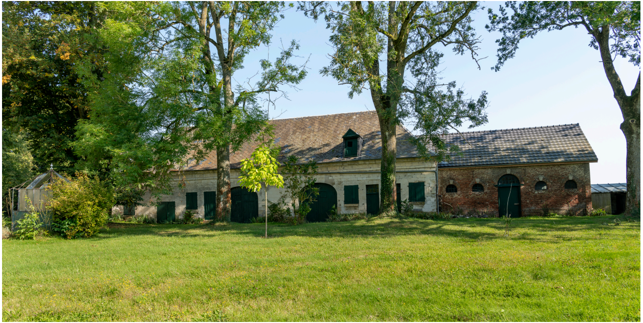
Anciens garages et écurie, vue depuis l'ouest.
