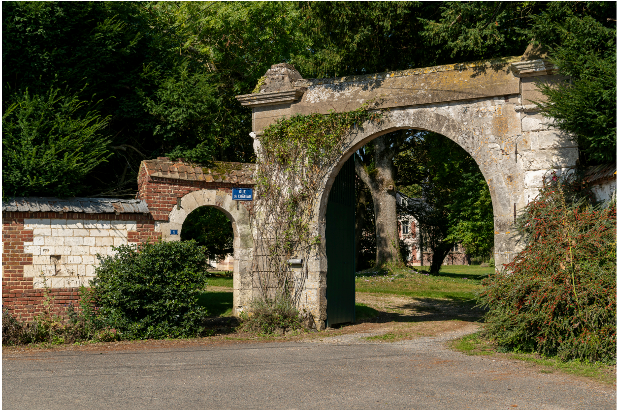
Porche et entrée piétonne.
