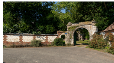
Vue générale de l'entrée depuis la rue du Château, vue depuis le sud. Phot. Marc Kérignard IVR32_20246000994NUCA
