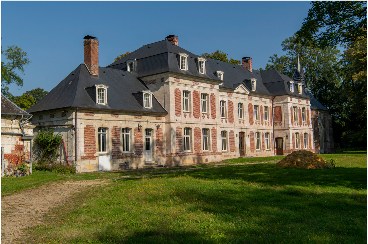
Château vu depuis le sud-est.
