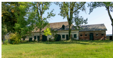
Anciens garages et écurie, vue depuis l'ouest. Phot. Marc Kérignard IVR32_20246001003NUCA
