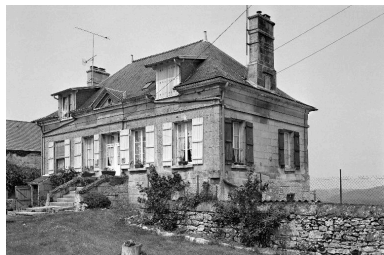
Vue générale, depuis le sud. Phot. Thierry Lefébure IVR22_19900200872X
