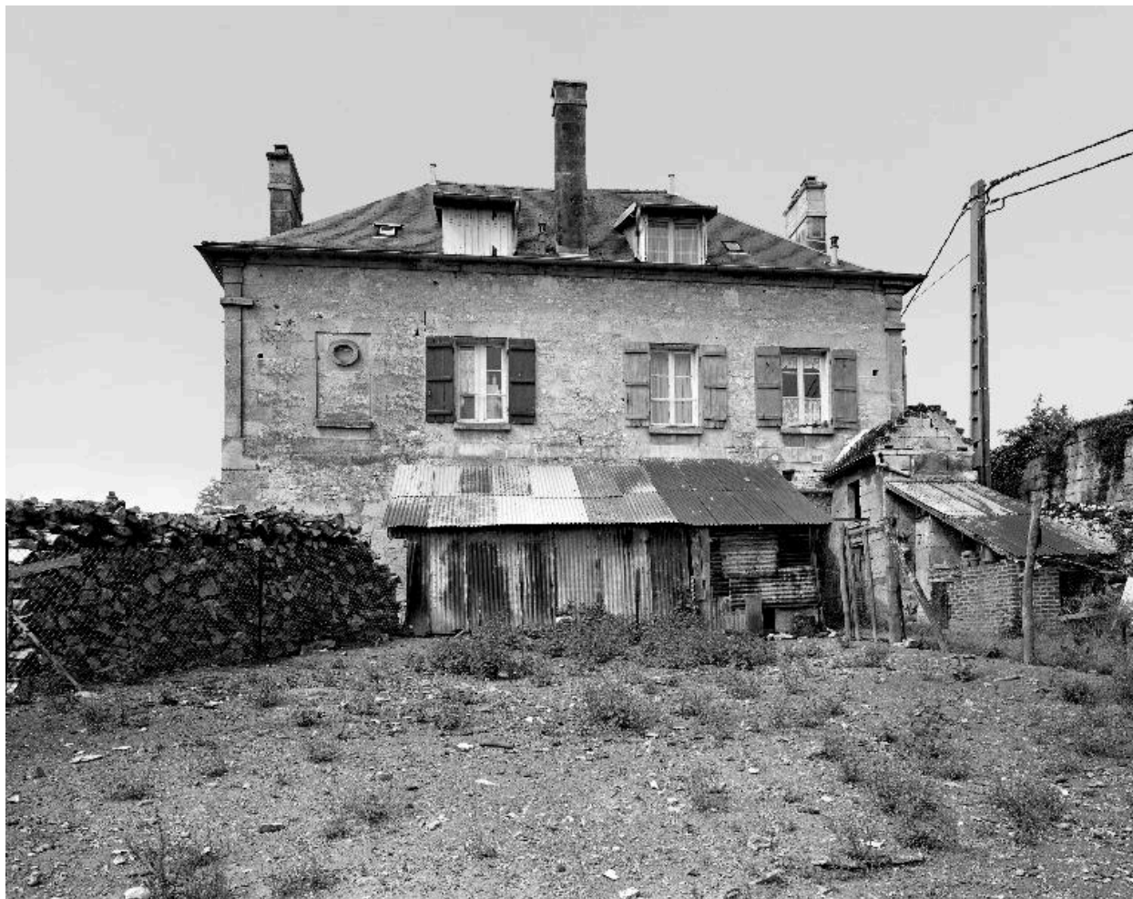
Vue générale de l'élévation arrière (nord-est).
