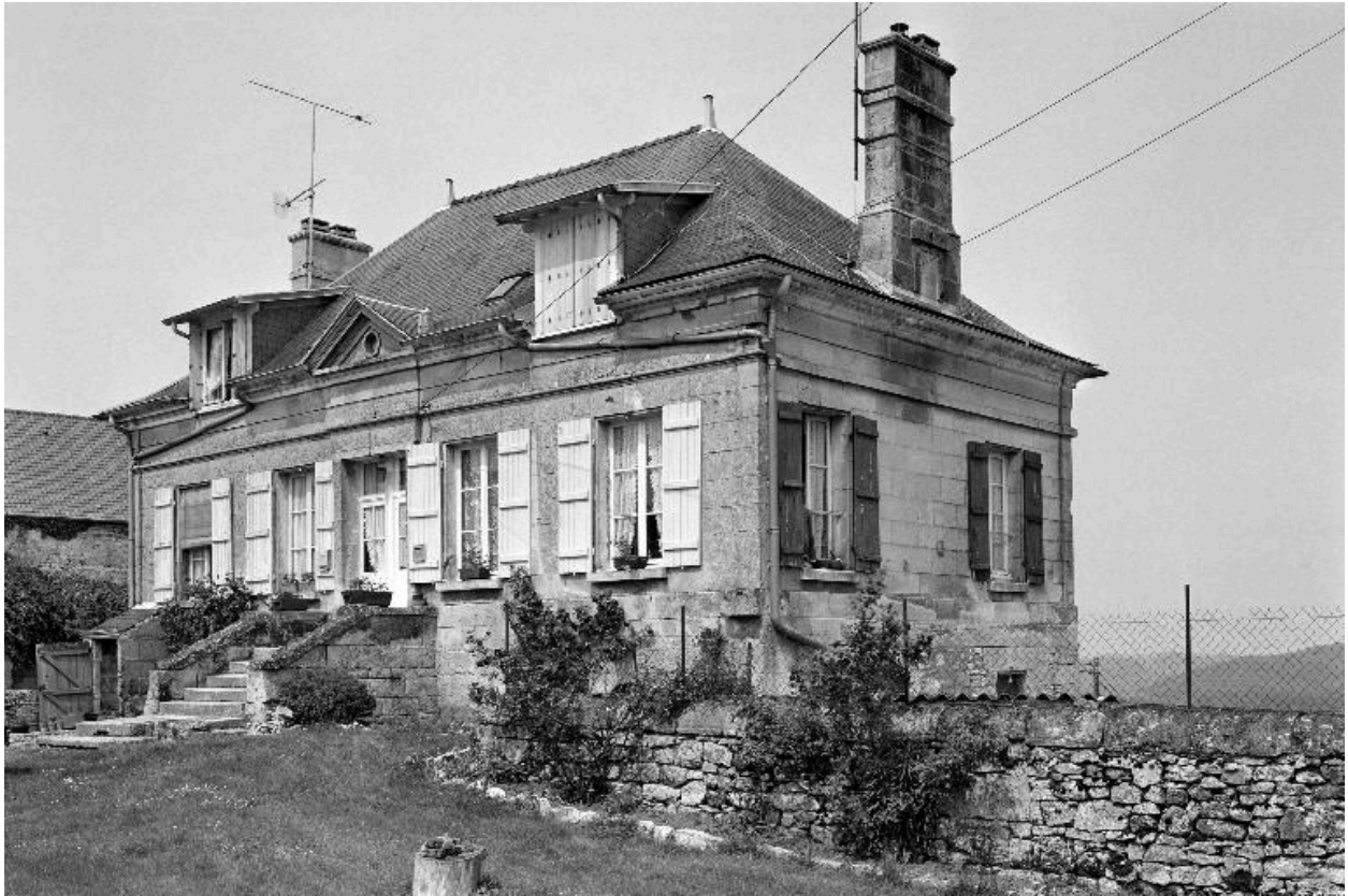
Vue générale, depuis le sud.
