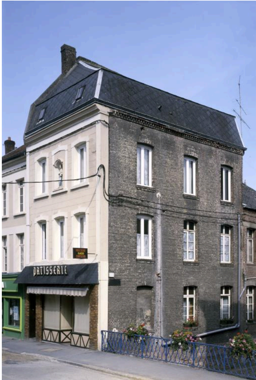
Vue de la façade sur rue de l'ancien moulin.
