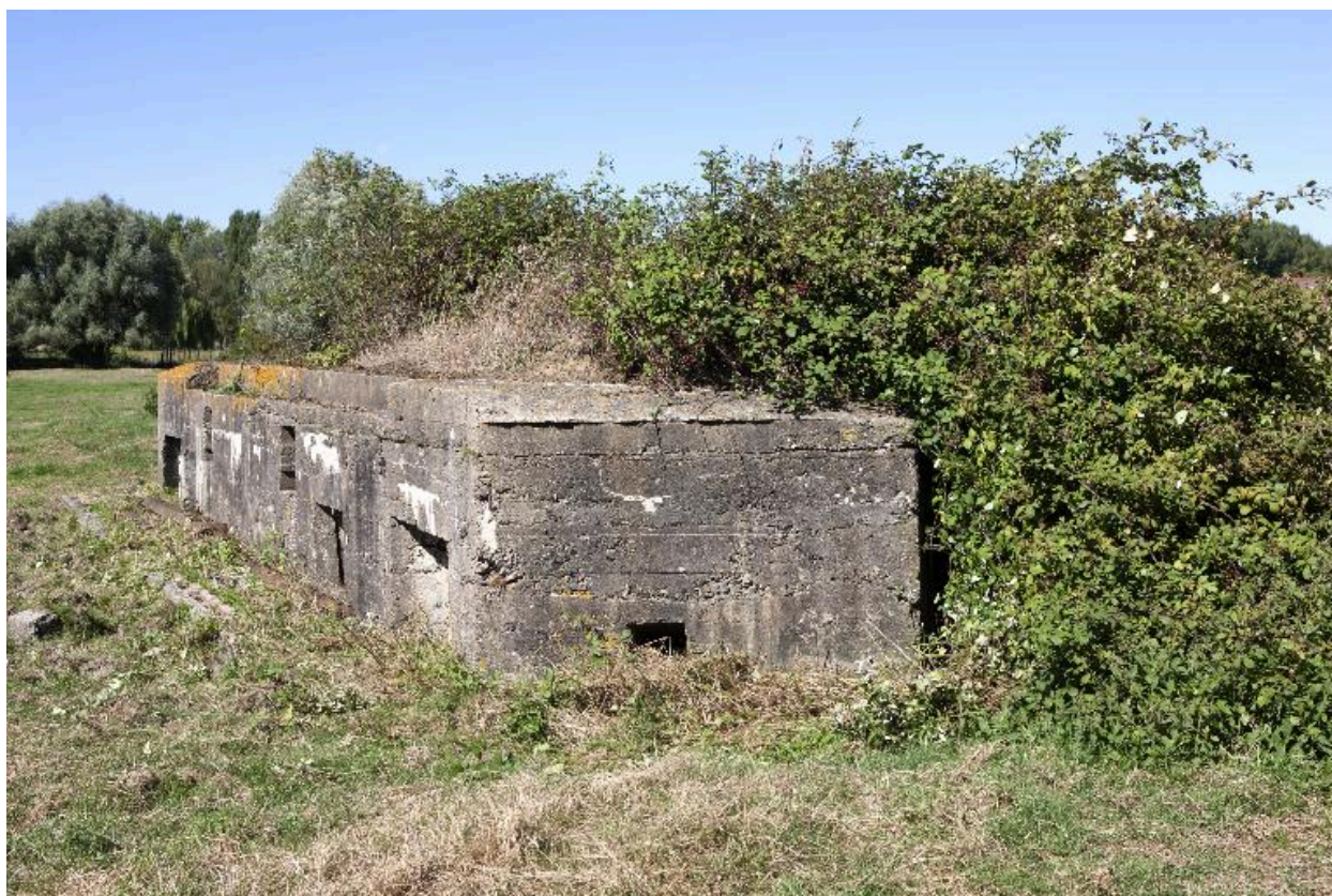
Vue générale vers le nord-ouest
