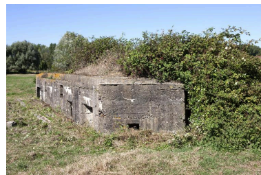
Vue générale vers le nord-ouest Phot. Pierre Thibaut IVR32_20165901340NUCA
