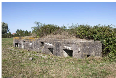
Vue générale vers le nord-ouest Phot. Pierre Thibaut IVR32_20165901341NUCA
