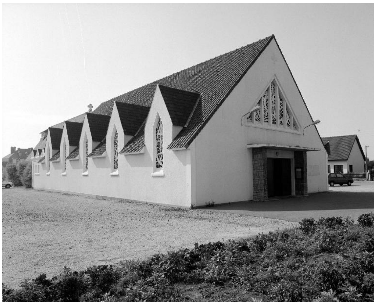
Vue d'angle sud-est.
