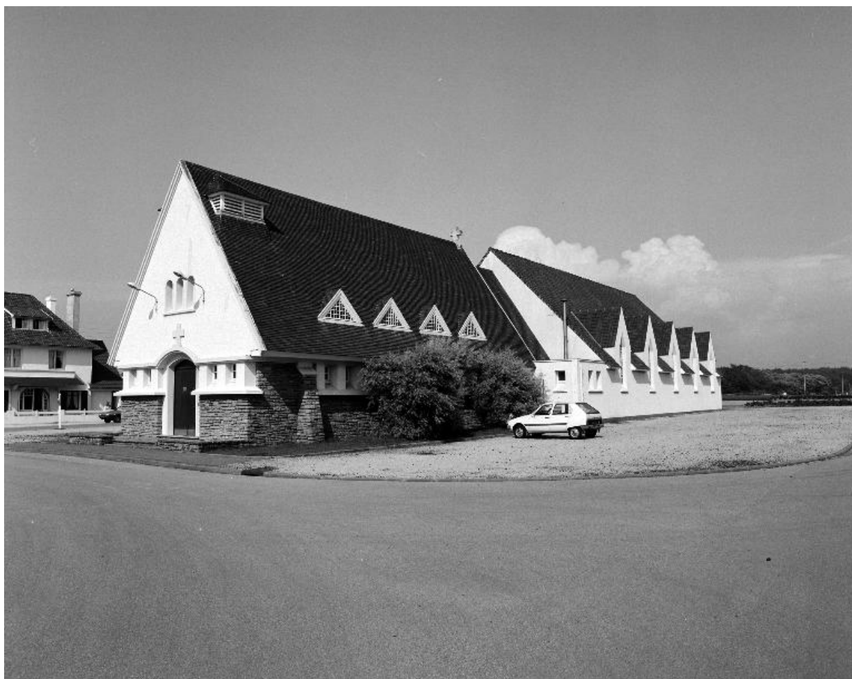
Vue d'angle sud-ouest.
