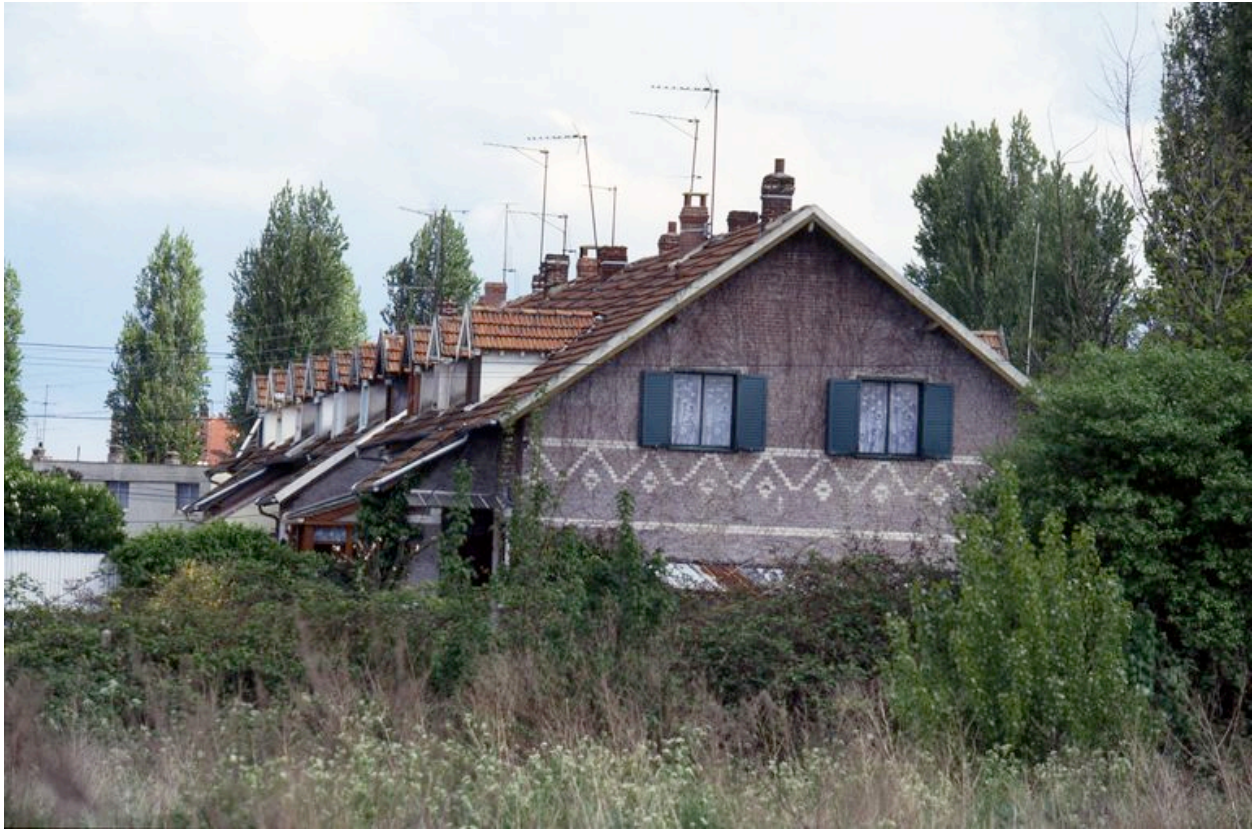
Immeuble à logements des ouvriers, vue prise en 1992. Alignement des lucarnes de l'étage de comble et détail des motifs en brique silico-calcaire.
