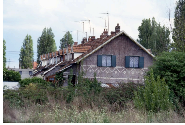
Immeuble à logements des ouvriers, vue prise en 1992. Alignement des lucarnes de l'étage de comble et détail des motifs en brique silico-calcaire. Phot. Benoît Dufournier IVR22_19926000036ZA
