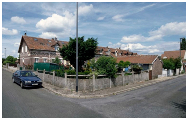
Vue générale de l'une des barres de logements. Phot. Thierry Lefébure IVR22_20106000420NUCA
