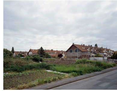
Immeubles à logements ouvriers d'une cité de la Cerabati. Phot. Thierry Lefébure IVR22_20106000368VA
