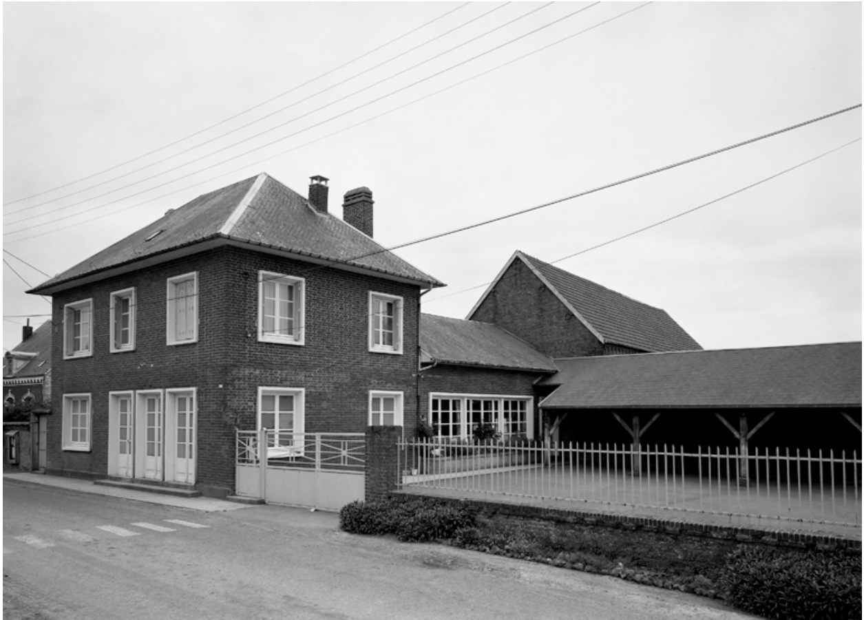
Vue d'ensemble ouest.
