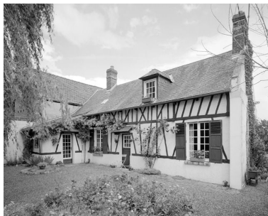
Logis. Vue générale. Phot. Jean-Michel Perrin IVR22_19856000985V
