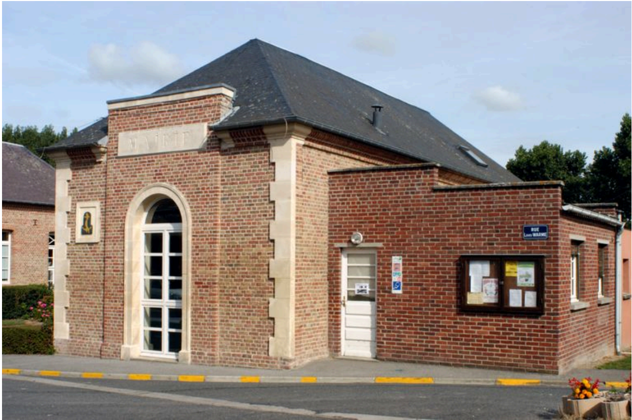
La mairie, vue du sud-est.
