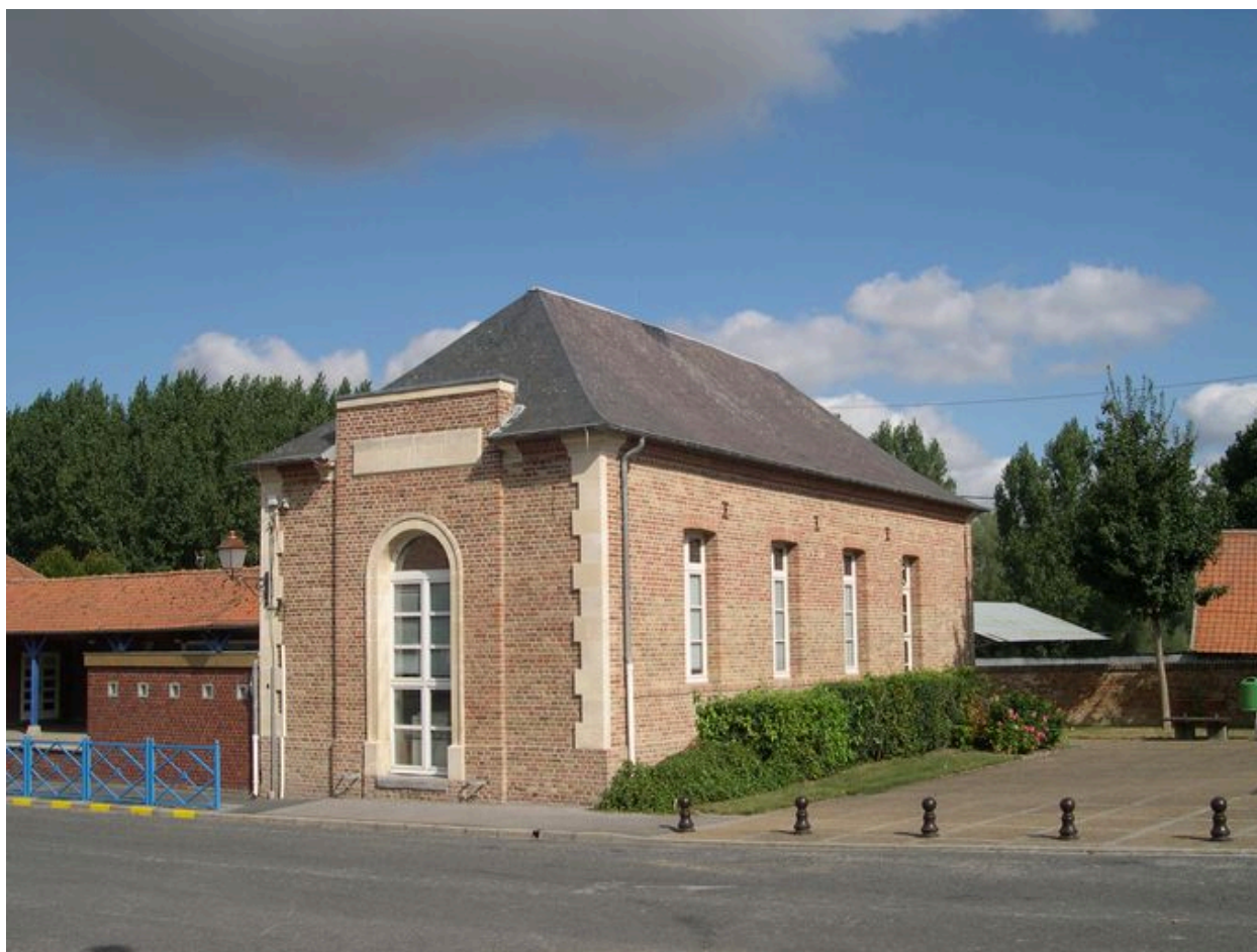
L'école, vue du sud-est.
