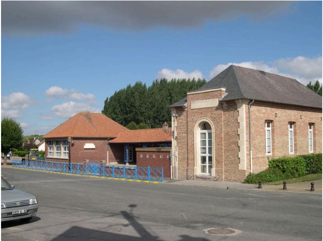
L'école et les extensions réalisées au milieu du 20e siècle, à l'ouest.
