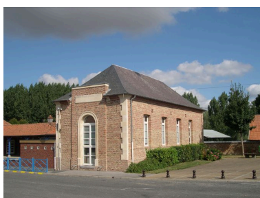
L'école, vue du sud-est.
