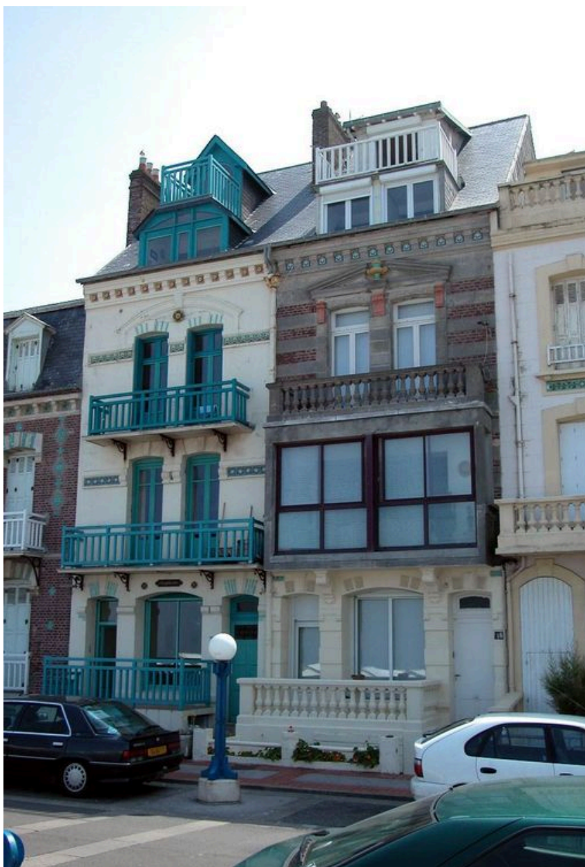
Vue d'ensemble depuis l'esplanade.
