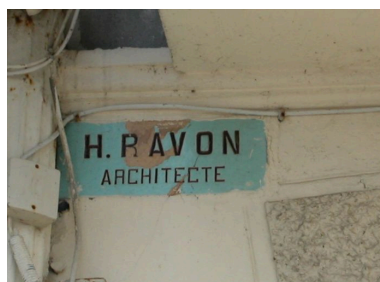
Détail du carreau de céramique portant signature de l'architecte H. Ravon. Phot. Elisabeth Justome IVR22_20058003220NUCA
