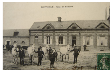
Vue de la ferme de Romiotte en 1913. Phot. Inès Guérin IVR22_20068005924NUCAB
