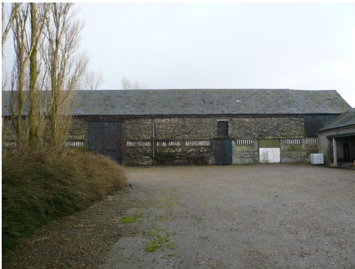
Vue de la grange au sud.
