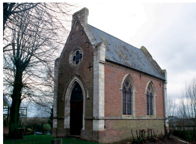
Vue générale. Phot. Irwin Leullier IVR22_19998000423ZA
