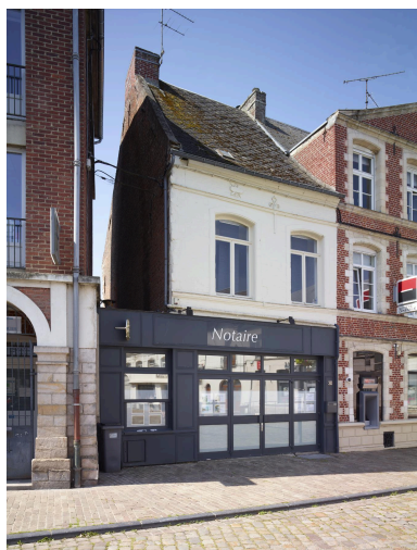
Maison avec façade portant un décor de confrérie d'archets - 30, place du Général-Leclerc. Phot. Pierre Thibaut IVR32_20235901079NUCA
