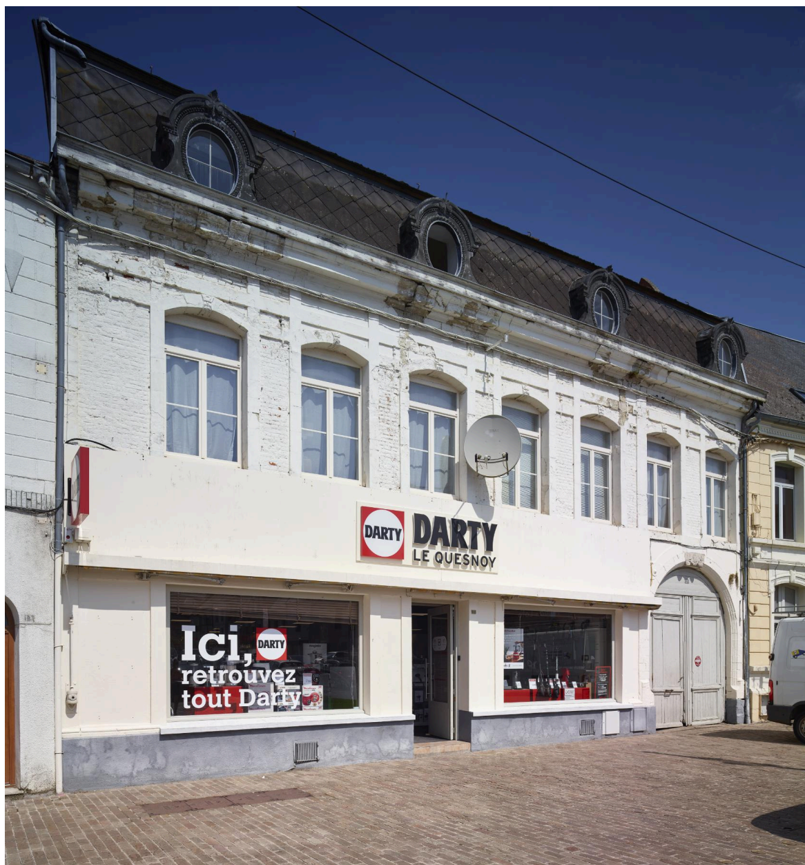
Façade principale, vue de face depuis la place.
