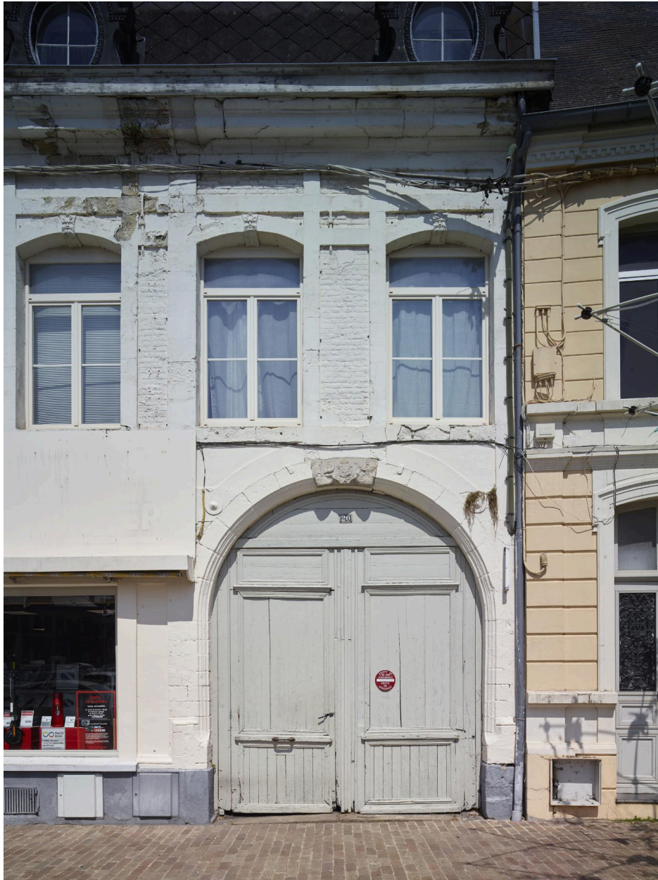
Détail de la travée accueillant la porte cochère, dont la clef de voûte est ornée de motif rappelant Charles Quint (blason couronné entouré de la Toison d'or et encadré par deux nefs).
