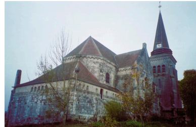
Façade postérieure sud. Phot. Gilles-Henri Bailly IVR22_20158005284NUCA
