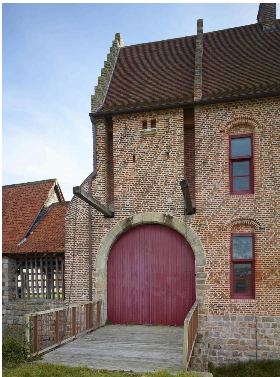
Tour-porche et porterie. Vue depuis la rue.
