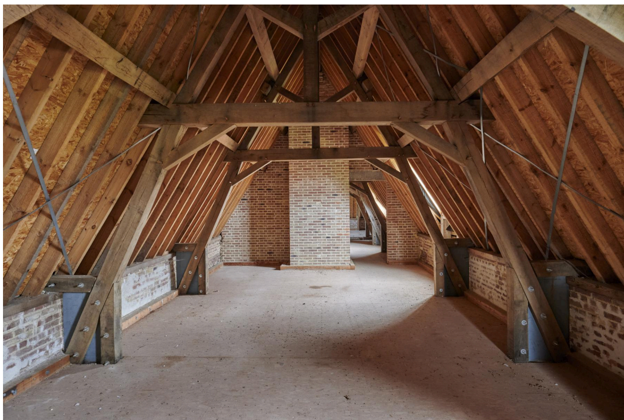
Combles. Logis du XVIIe siècle.
