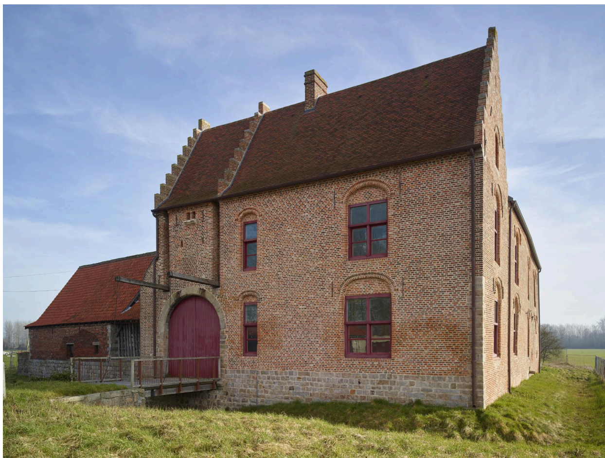
Façade sur rue. Logis du XVIe siècle.
