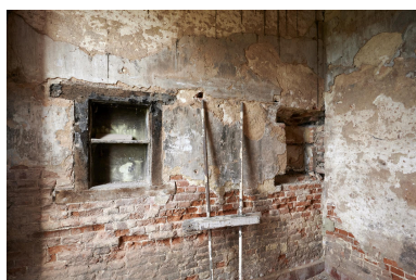
Rez-de-chaussée. Réduit du logis du XVIe siècle.
