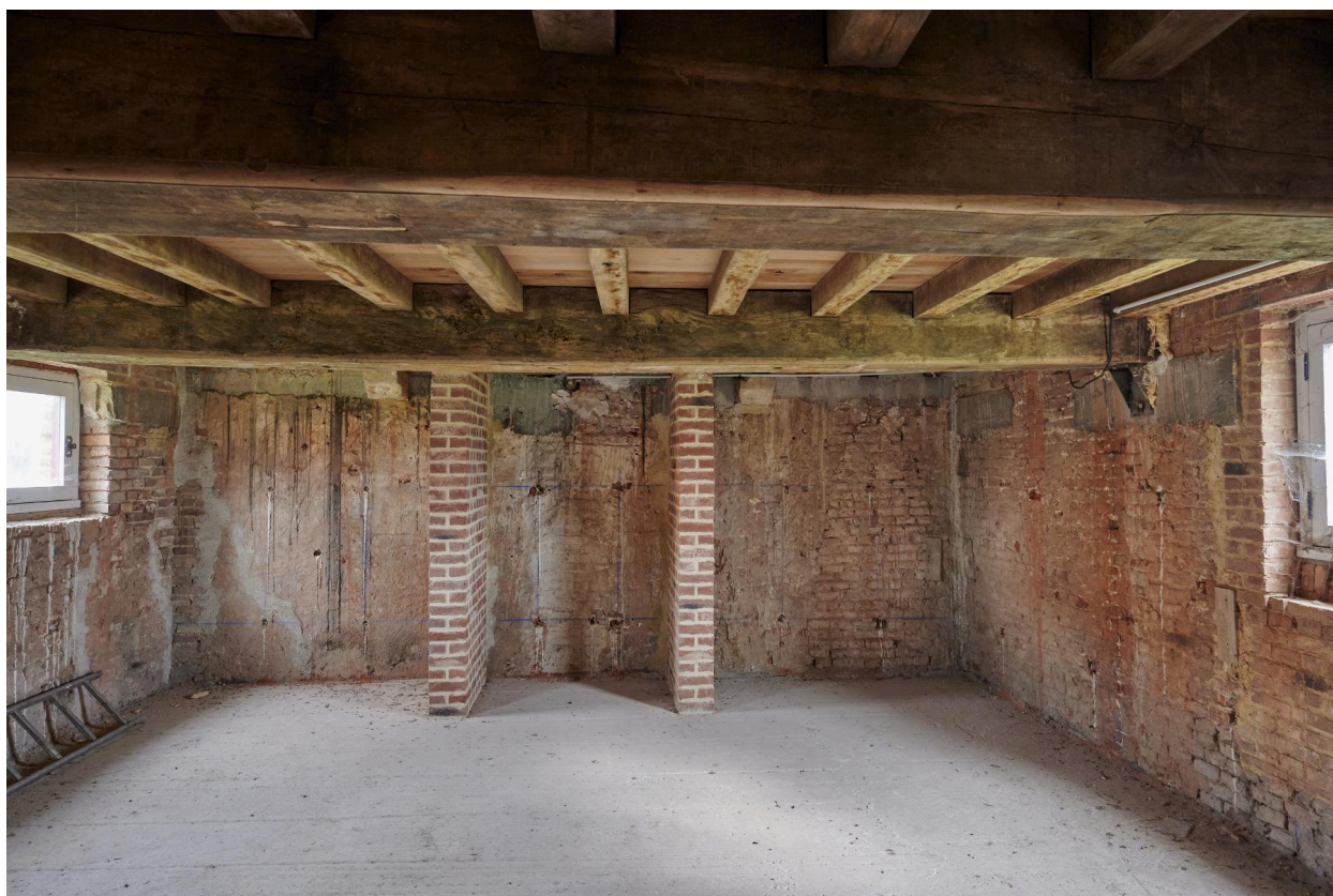
Rez-de-chaussée. Logis du XVIIe siècle. Arrière-cuisine.
