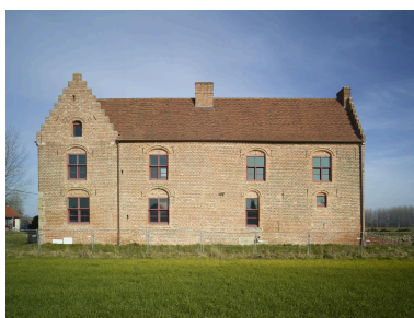
Façade sud. Phot. Pierre Thibaut IVR32_20236200109NUCA
