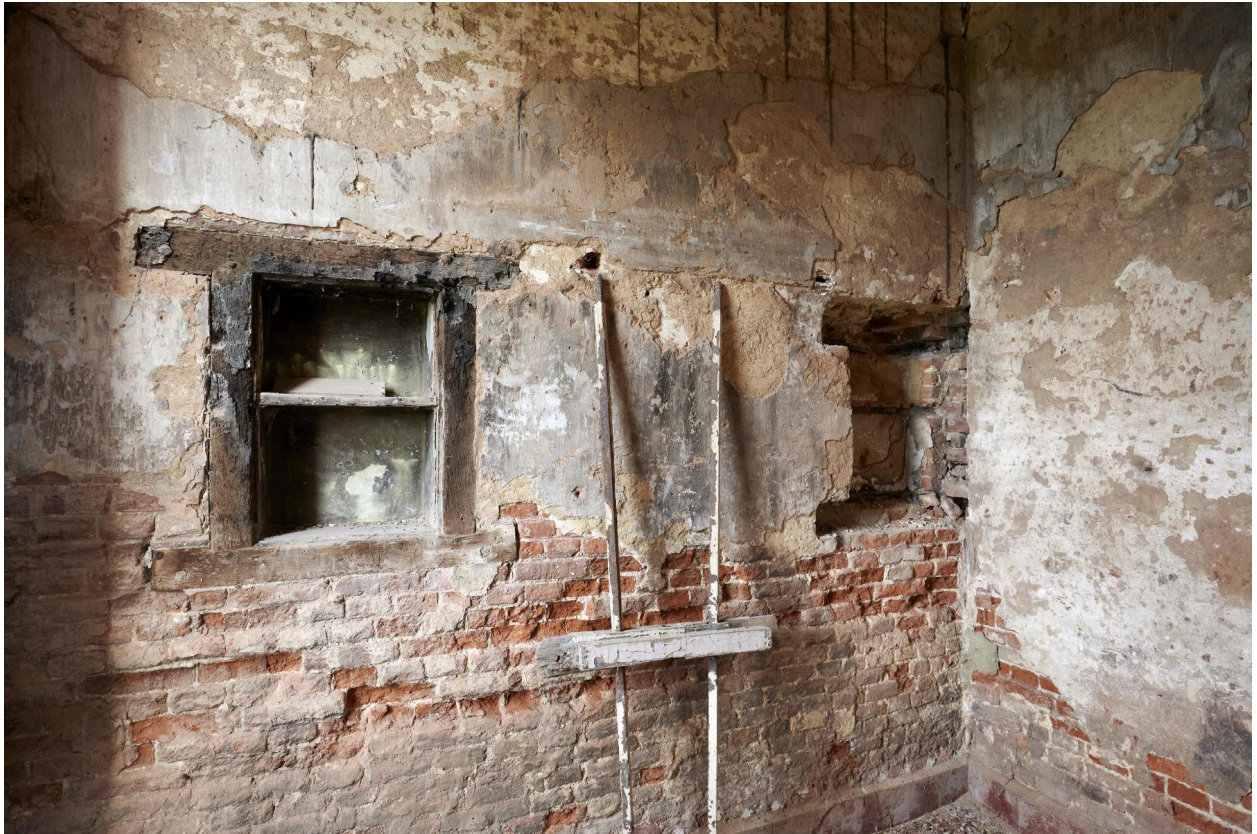
Rez-de-chaussée. Réduit du logis du XVIe siècle.
