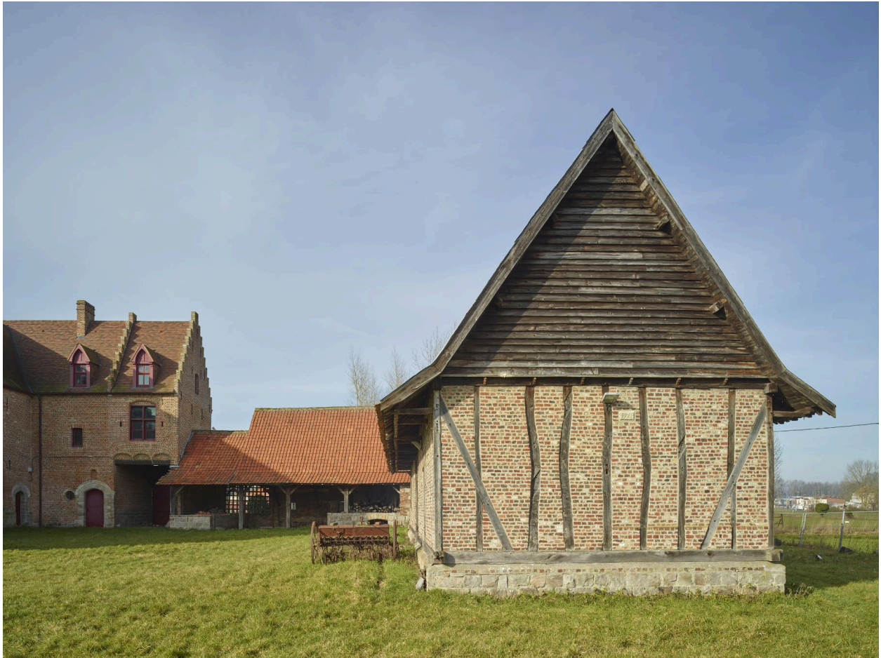
Grange nord. Vue du pignon prise depuis l'est du domaine.
