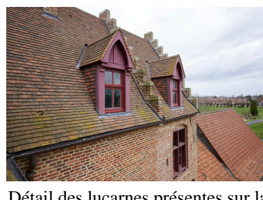
Détail des lucarnes présentes sur la tour porche et le logis du XVIe siècle. Phot. Pierre Thibaut IVR32_20236200134NUCA
