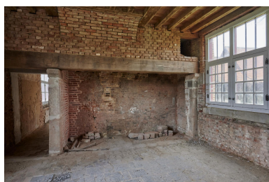
Rez-de-chaussée. Logis du XVIIe siècle. Cuisine et cheminée monumentale. Phot. Pierre Thibaut IVR32_20236200145NUCA
