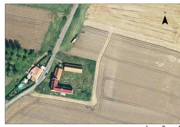
Orthophotographie (source : IGN. Photothèque nationale. 2015). Repro. Jean-Marc Ramette IVR32_20226205012NUCA
