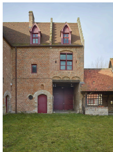
Tour-porche et porterie. Vue depuis la cour intérieure. Porte d'entrée du logis XVIe siècle directement à gauche. Phot. Pierre Thibaut IVR32_20236200114NUCA
