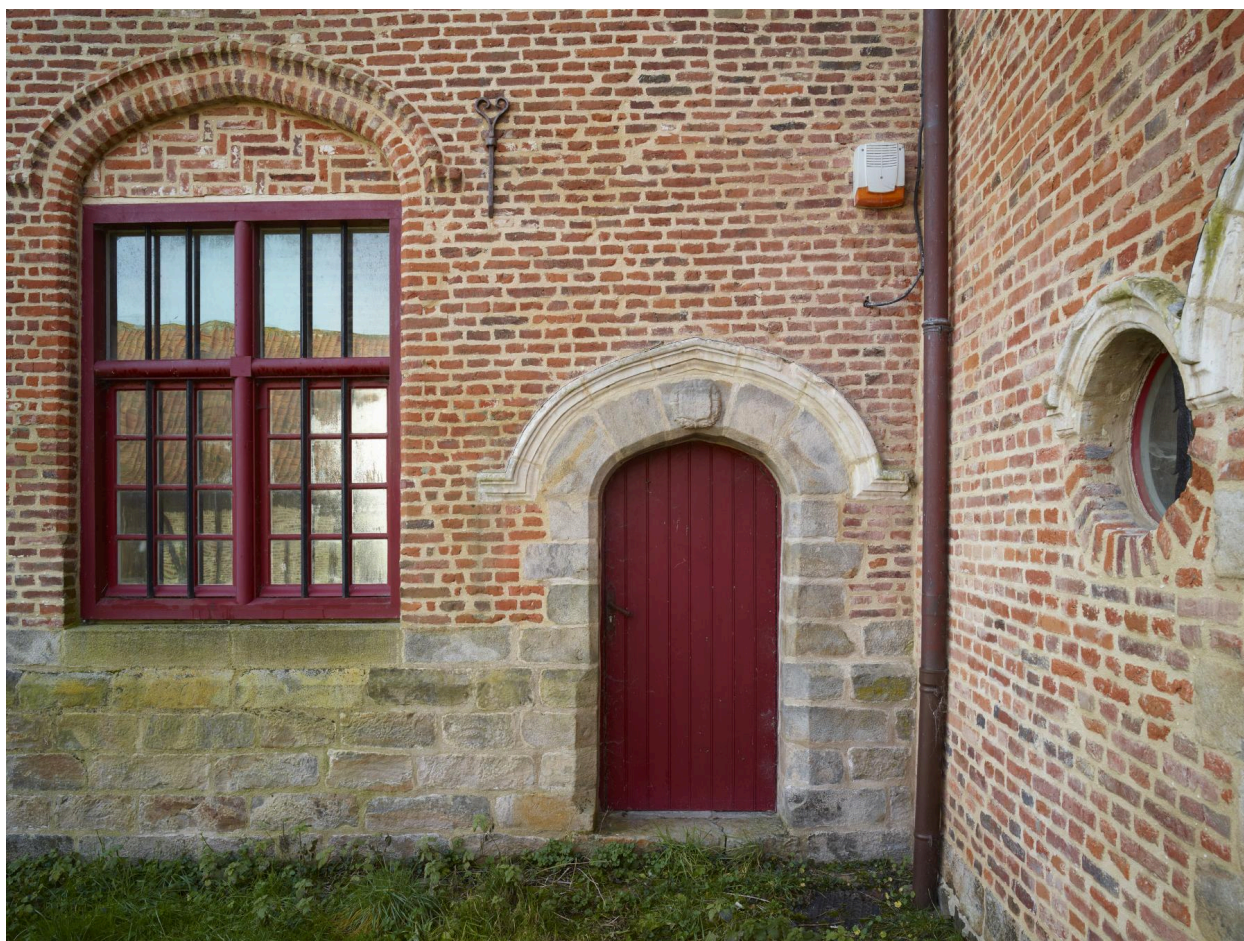
Porte d'accès principale au logis du XVIIe siècle.
