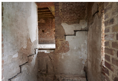
Premier étage. Logis du XVIe siècle. Ancienne cage d'escalier desservant les étages et la tour porche. Phot. Pierre Thibaut IVR32_20236200130NUCA
