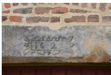
Détail de la porte menant à la cave du logis du XVIIe siècle. Chronographe "1629". Phot. Pierre Thibaut IVR32_20236200155NUCA
