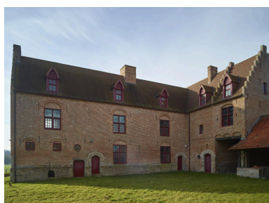
Vue des logis prise depuis l'intérieur de la cour. Phot. Pierre Thibaut
