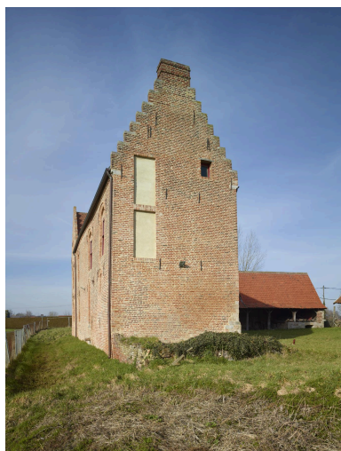
Mur pignon du logis. Depuis l'est. Phot. Pierre Thibaut IVR32_20236200119NUCA
