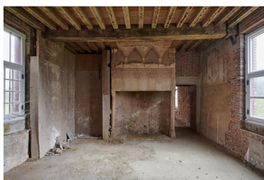
Rez-de-chaussée. Logis du XVIIe siècle. Salle principale avec cheminée monumentale. Phot. Pierre Thibaut IVR32_20236200148NUCA
