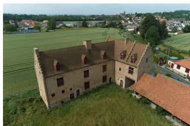
Vue aérienne du logis. Phot. Marc Kérignard IVR32_20236200576NUCA
