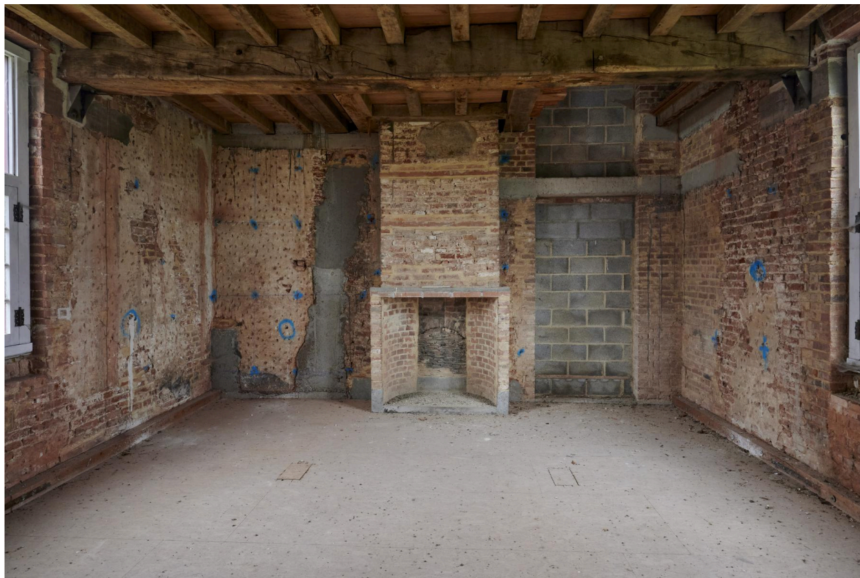
Premier étage. Logis du XVII e siècle. Dernière salle à l'est du bâtiment. Âtre de cheminée original. Accès vers les combles.
