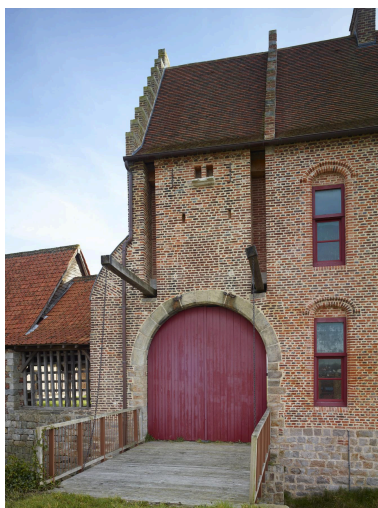
Tour-porche et porterie. Vue depuis la rue. Phot. Pierre Thibaut IVR32_20236200112NUCA
