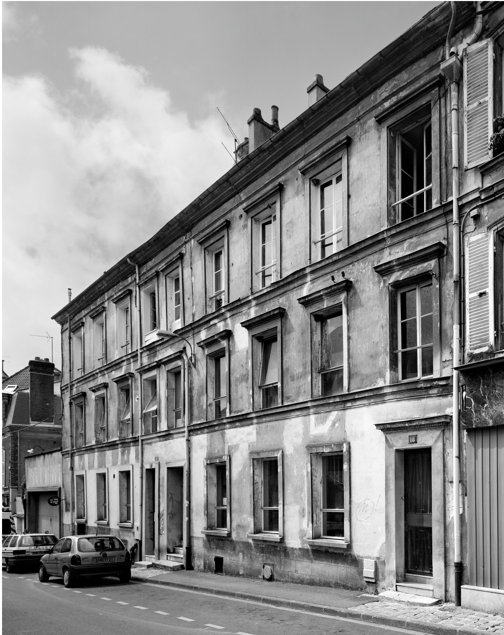
Vue de la façade sur rue.
