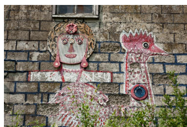
Détail du pignon du bâtiment annexe de la grange : représentation de Marianne et du coq français.
