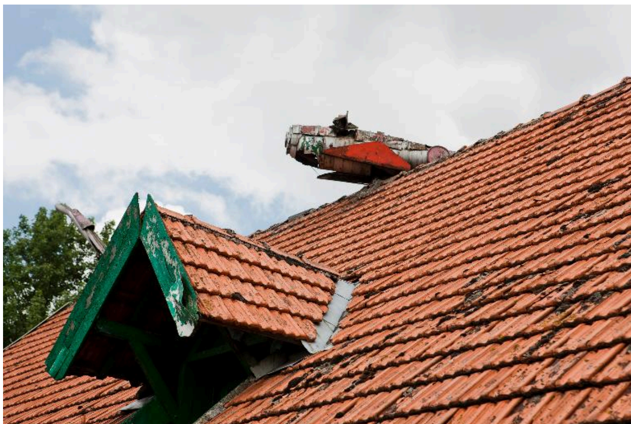
Avion sur le toit de la porcherie.
