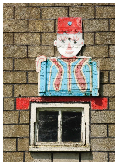
Pignon de l'ancienne porcherie : détail du tirailleur sénégalais.
