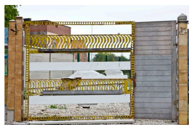
Impasse Boileau, porte cochère, 2010. Phot. Hubert Bouvet IVR31_20106201363NUCA
