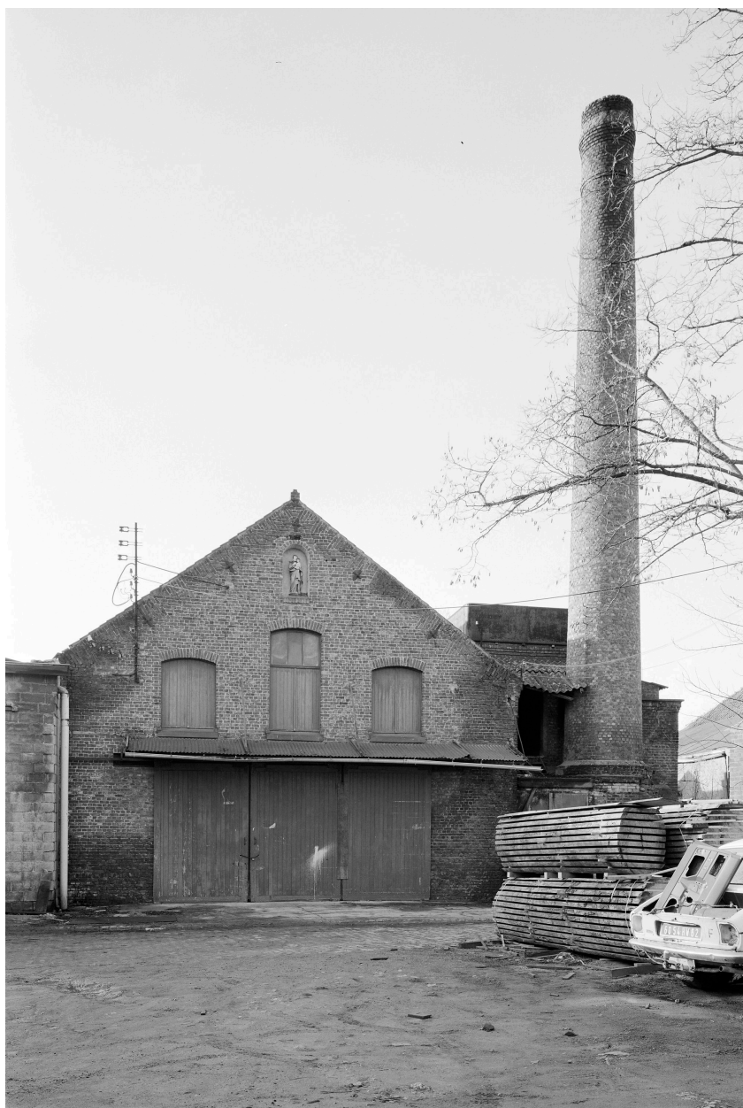
Atelier de fabrication, cheminée d'usine.
