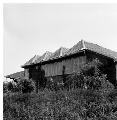
Magasin industriel. Phot. Philippe Dapvril IVR31_19885900861X
