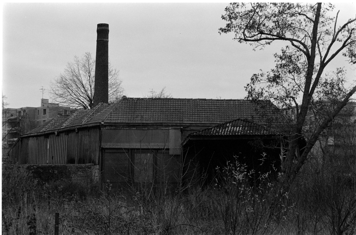
Magasin industriel. Vue prise vers le sud.
