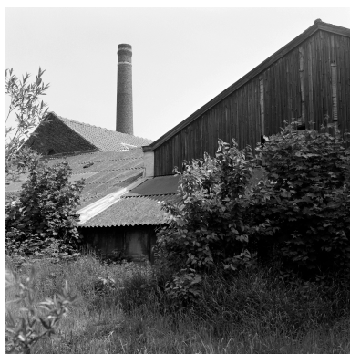
Atelier de fabrication, hangar. Façade postérieure sur l'ancienne Lys. Phot. Philippe Dapvril IVR31_19885900891X
