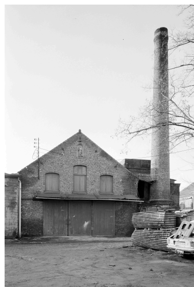
Atelier de fabrication, cheminée d'usine. Phot. Philippe Dapvril IVR31_19885900048X
