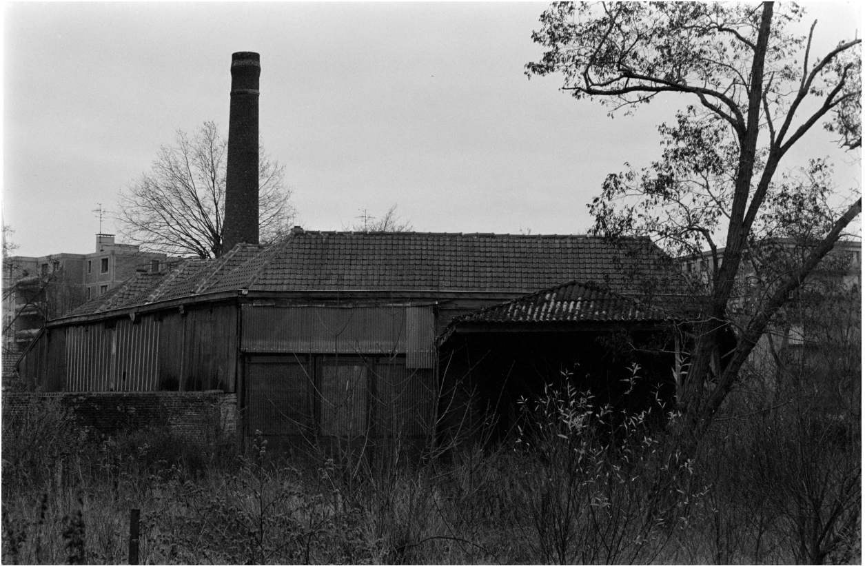
Magasin industriel. Vue prise vers le sud.
