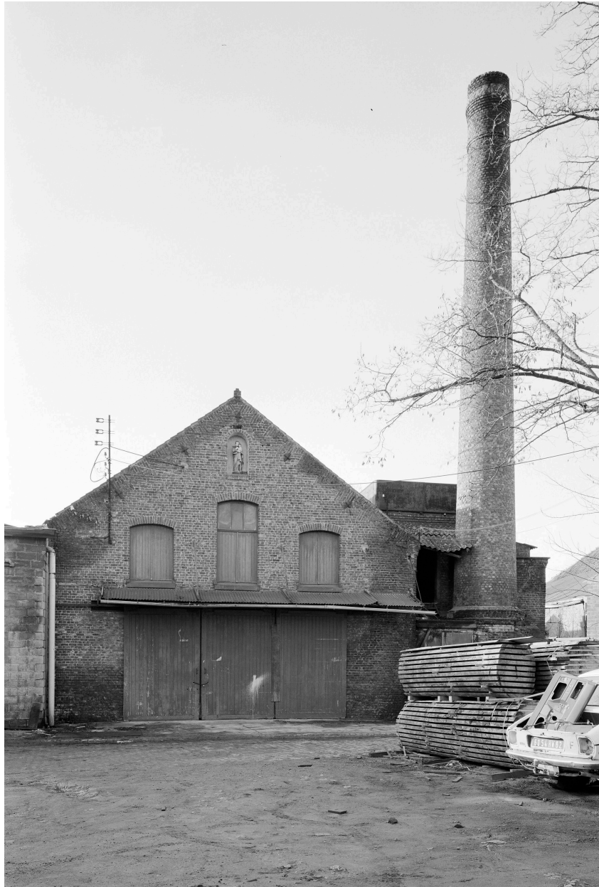
Atelier de fabrication, cheminée d'usine.
