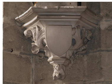
Vue de détail, culot. Phot. Julien Marasi IVR31_20106207180NUCA
