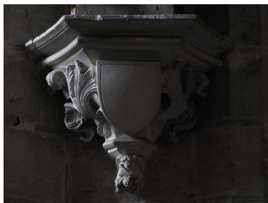
Vue de détail, culot. Phot. Julien Marasi IVR31_20106207179NUCA
