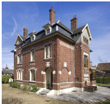
Vue générale. Phot. Thierry Lefébure IVR32_20170200119NUC2AQ
