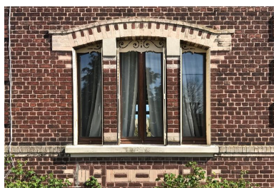
Détail d'une fenêtre en triplet. Phot. Bertrand Fournier IVR32_20170205050NUCA
