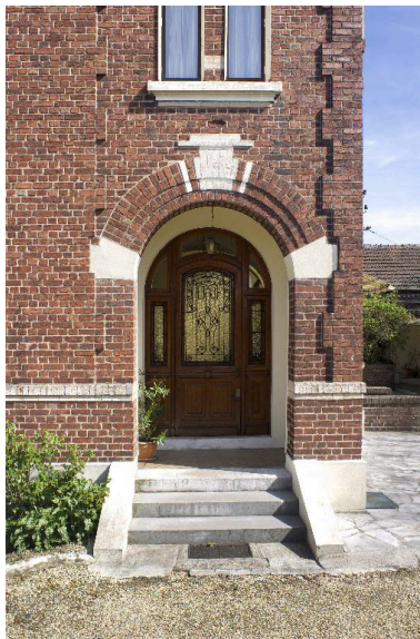
Porte d'entrée principale, vue générale. Phot. Thierry Lefébure IVR32_20170200120NUC2A
