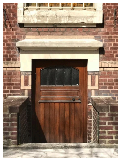
Détail de la porte de service en demi-sous-sol. Phot. Bertrand Fournier IVR32_20170205051NUCA
