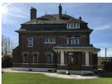
Vue générale, façade nord sur jardin. Phot. Bertrand Fournier IVR32_20170205048NUCA
