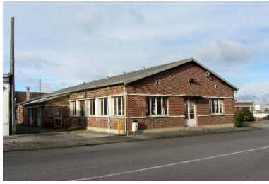
Restaurant d'entreprise. Phot. Bertrand Fournier IVR32_20168005019NUCA
