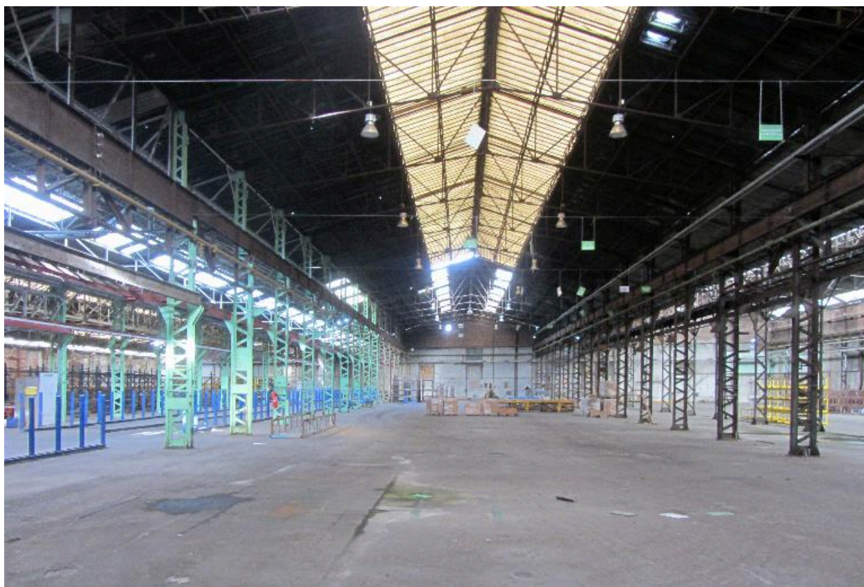
Vue intérieure d'une des halles de fabrication.
