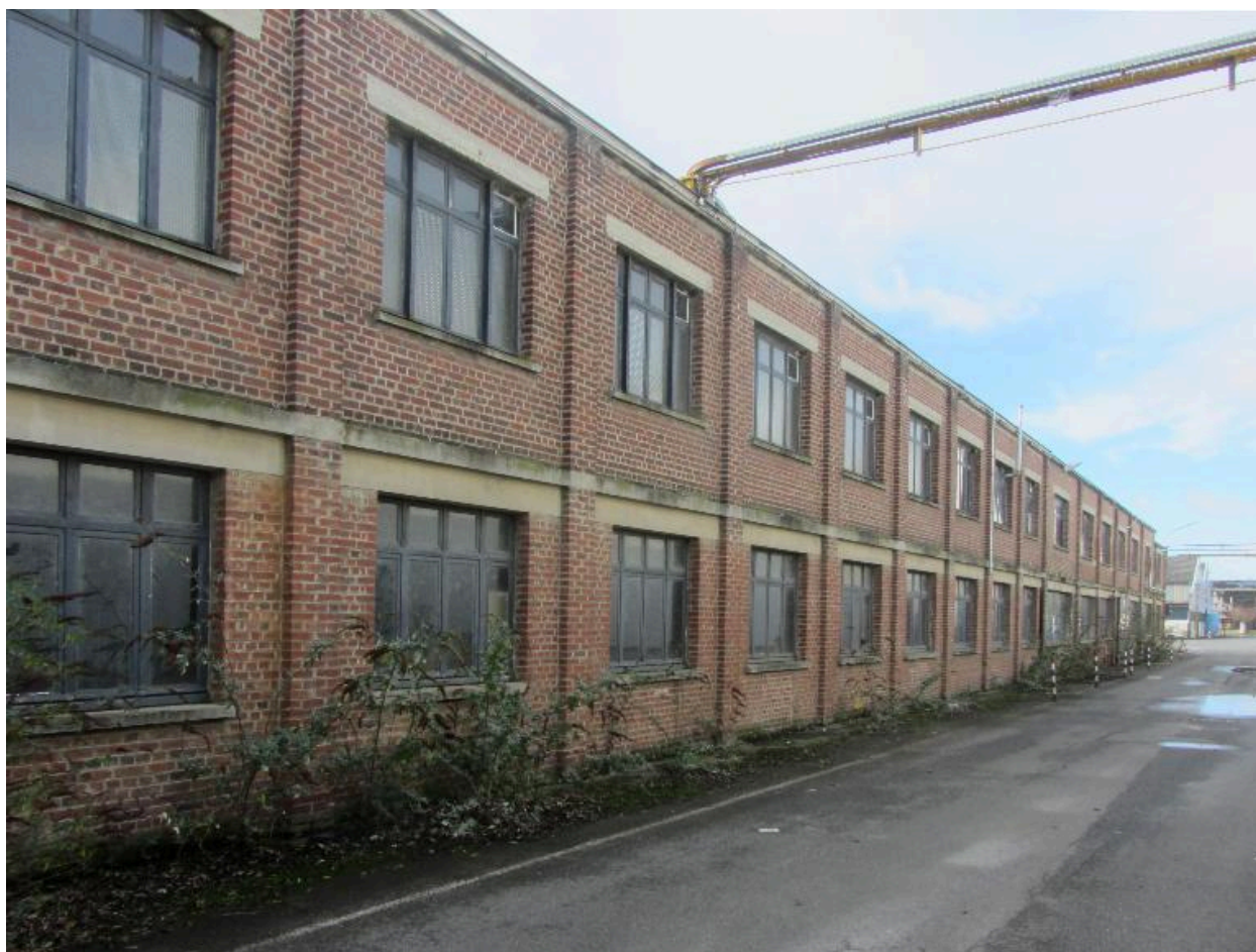
Façade longitudinale de l'atelier de maintenance.
