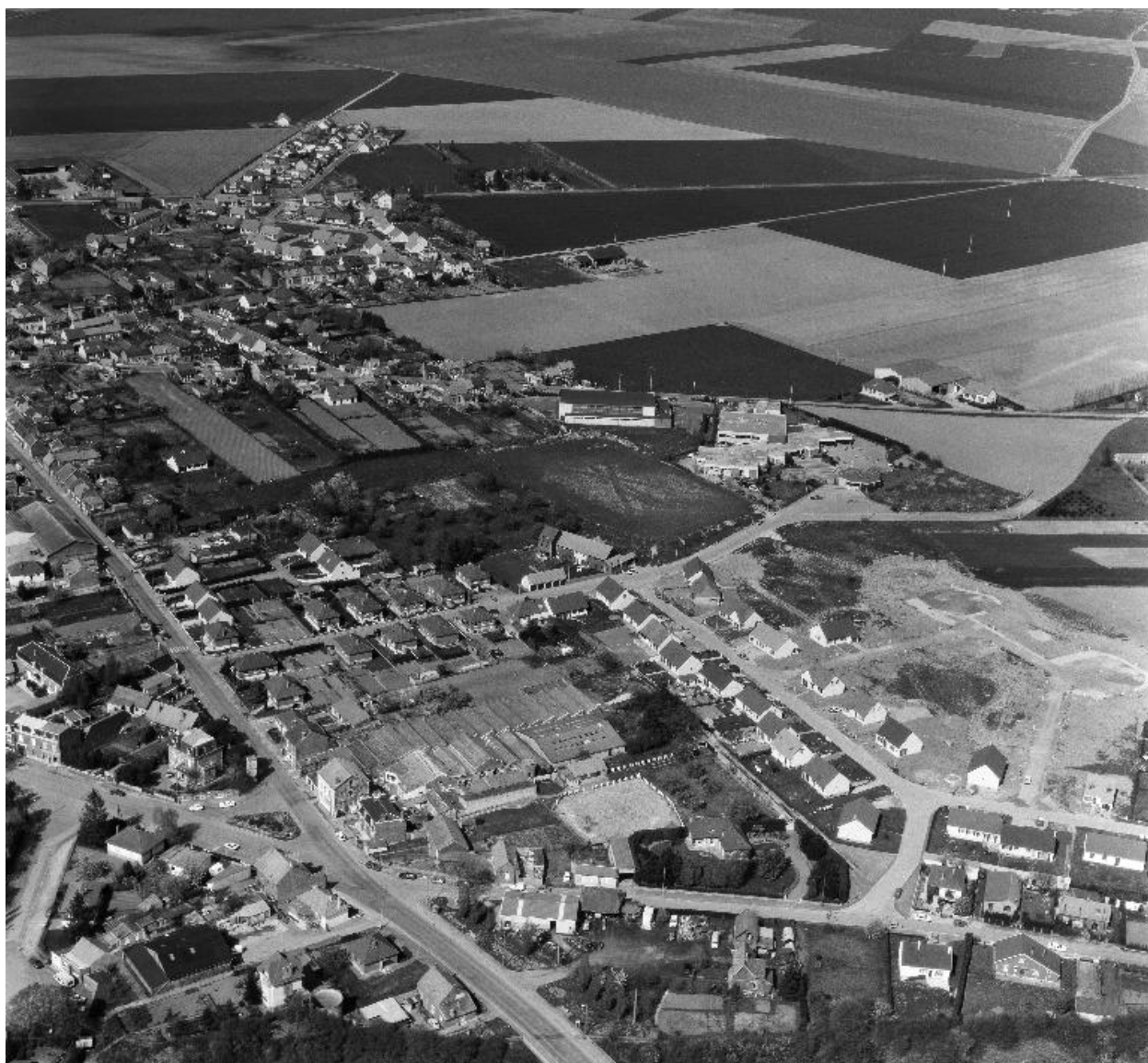
Vue aérienne, flanc sud-ouest.
