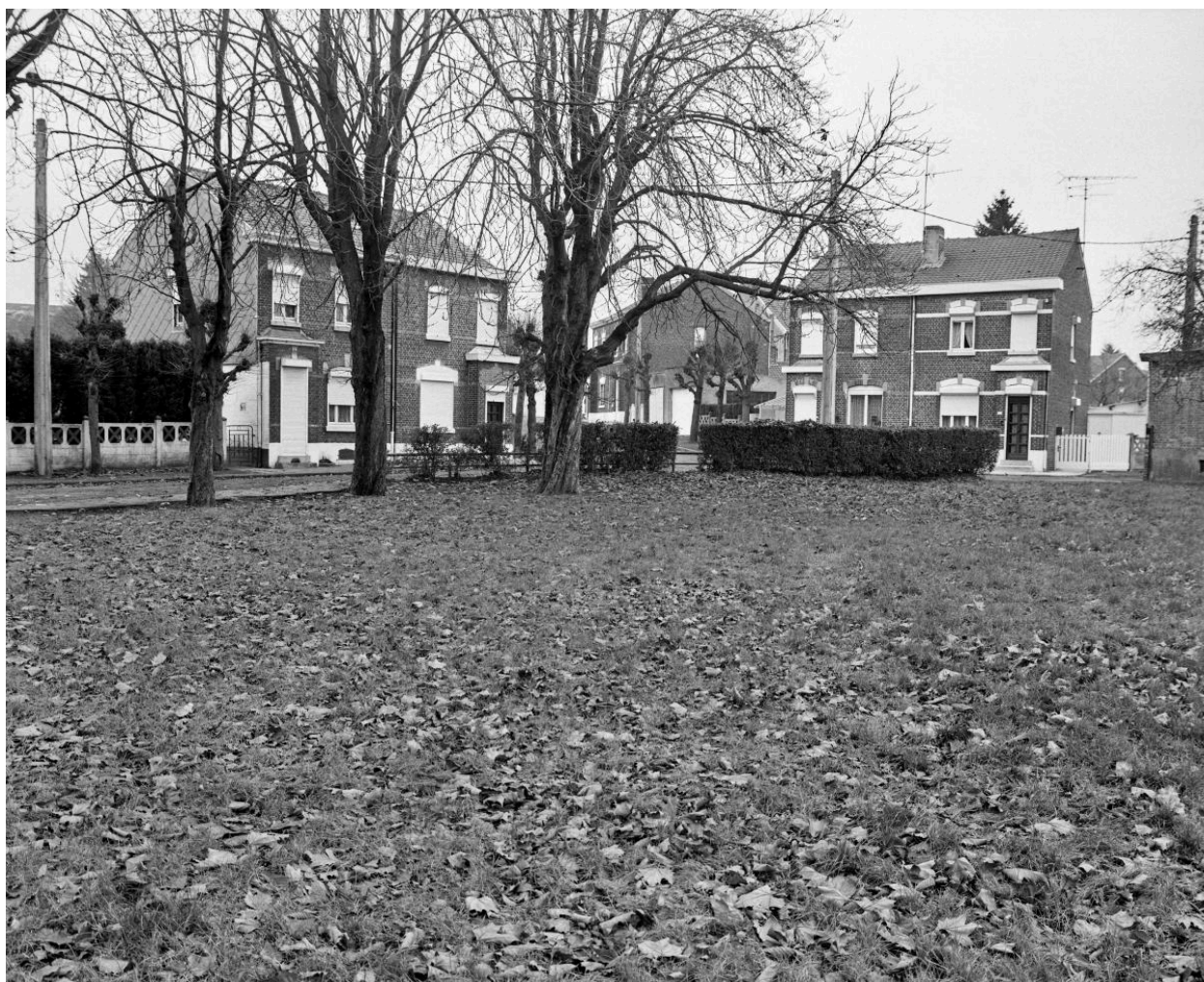
Cité de la centrale électrique de Maubeuge.
