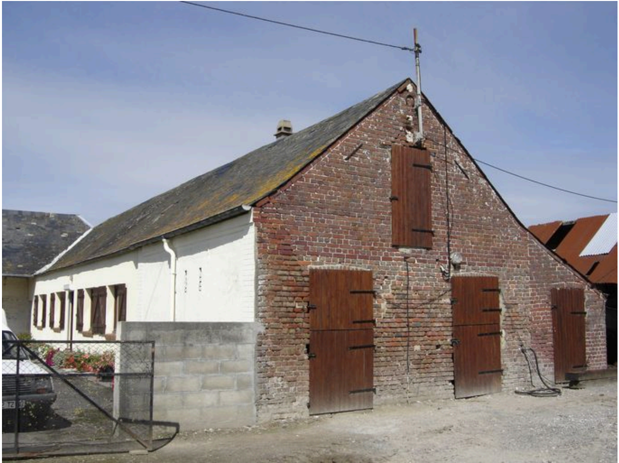
Vue latérale du logis avec bâtiments agricoles dans le prolongement.
